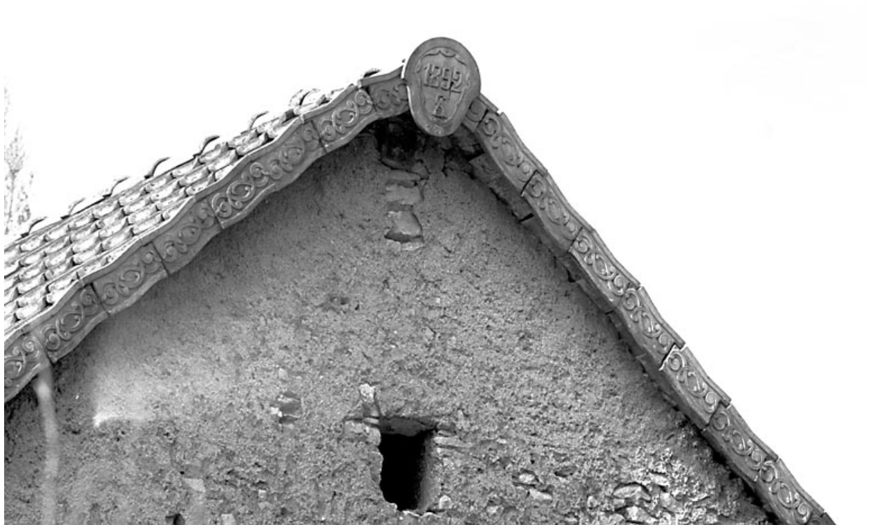
Vue du pignon droit de la remise.
