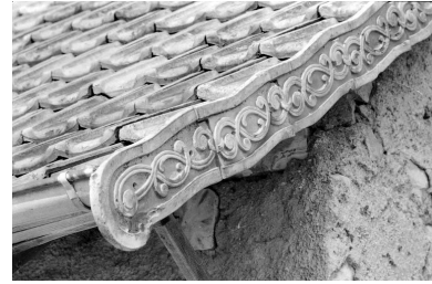
Pignon droit de la remise : détail. Phot. Bernard Lardière IVR43_19829000251Z
