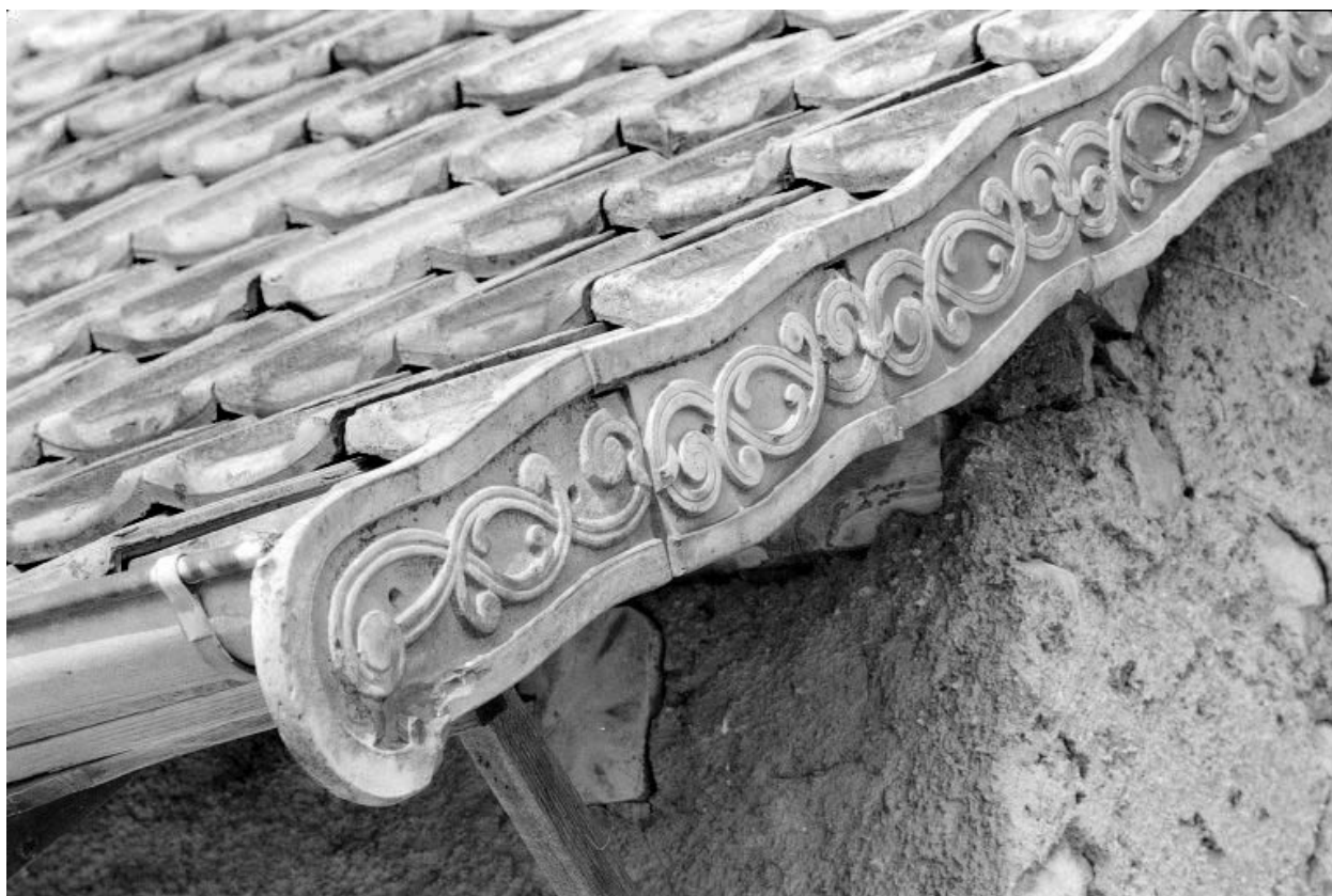
Pignon droit de la remise : détail.
