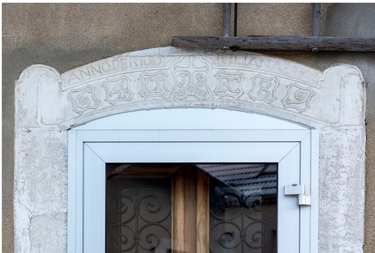
Façade antérieure : linteau avec inscription et datation.
