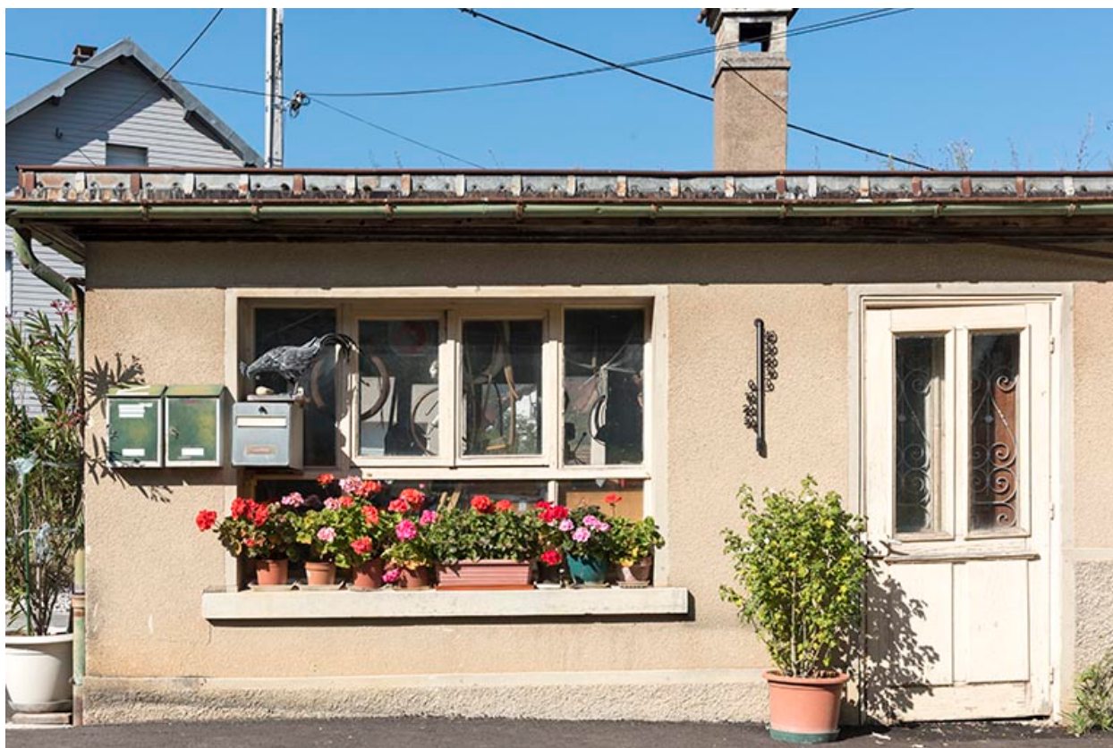
Ancien atelier de fabrication.
