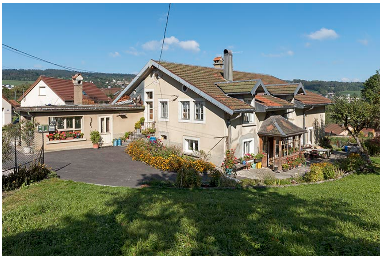
Façades postérieure et latérale droite.
