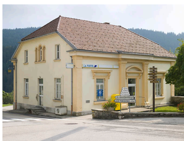
Façade antérieure et façade latérale gauche. Phot. Jérôme Mongreville IVR43_20082501029NUC2A
