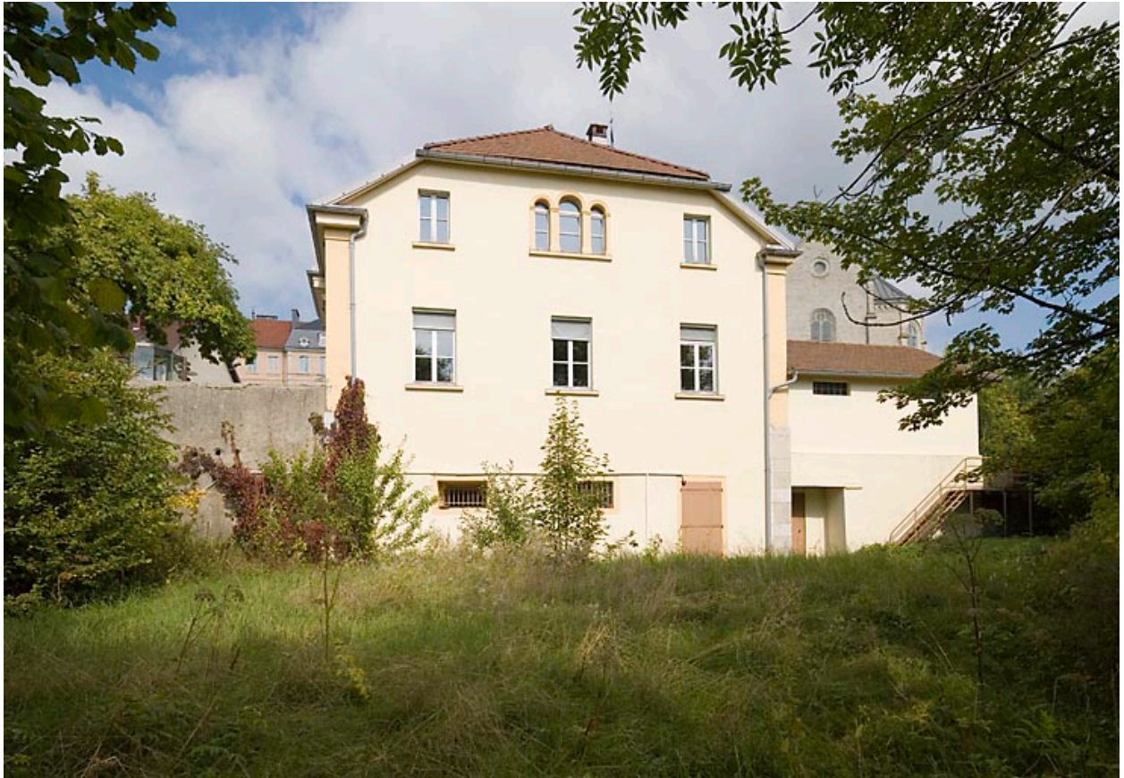
Façade latérale droite.
