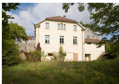
Façade latérale droite. Phot. Jérôme Mongreville IVR43_20082501028NUC2A
