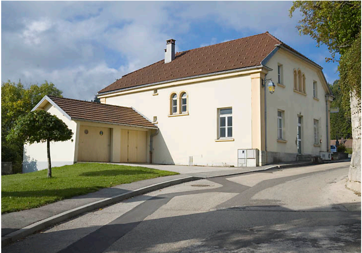
Façade postérieure et façade latérale gauche.
