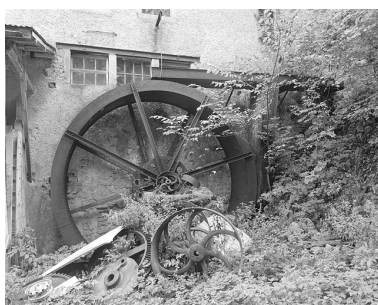
Roue métallique extérieure. Phot. Jérôme Mongreville IVR43_19963901314X
