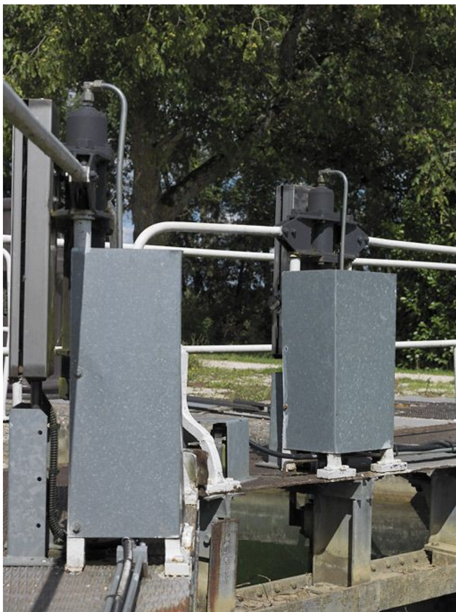
Détail des portes du sas.
