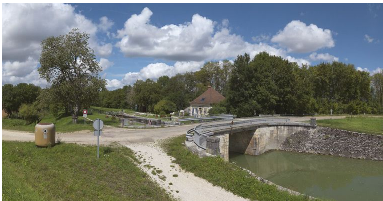
Vue d'ensemble du site, pris d'aval.
