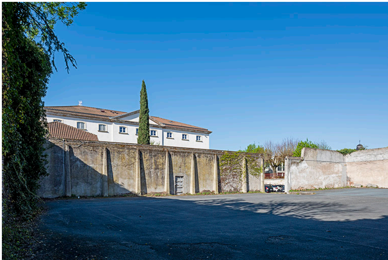
Grande cour de la prison, vue vers le nord-ouest.
