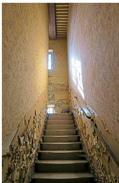
Première volée de l'escalier nord des prisonniers. Phot. Nicolas Boffy IVR26_20257100391NUC2A
