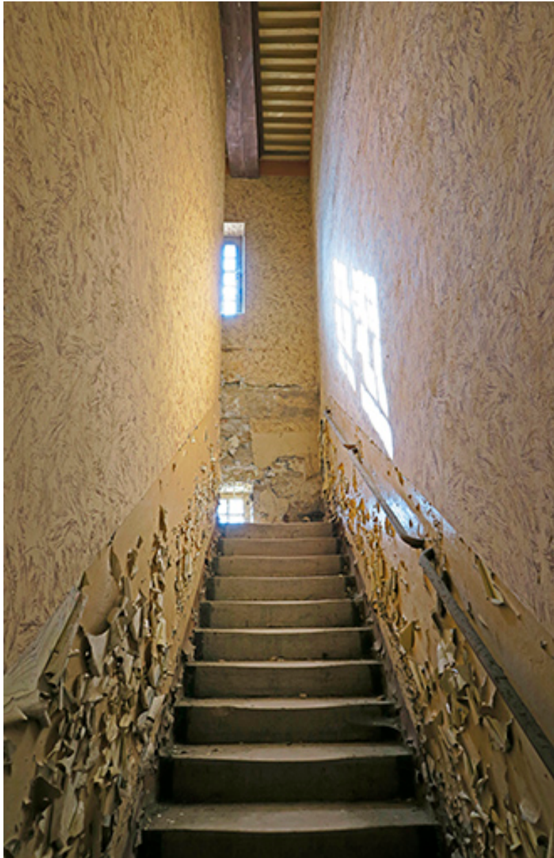
Première volée de l'escalier nord des prisonniers.
