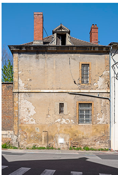
Pignon sud vu depuis la place des Carmélites. Phot. Aline Thomas IVR26_20257100401NUC4A
