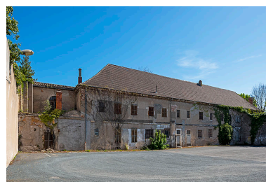
Façade de la prison depuis la grande cour. Phot. Aline Thomas IVR26_20257100400NUC4A
