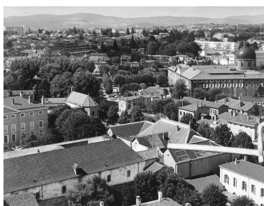
Vue aérienne de la façade postérieure de la prison (en bas à gauche). Autr. Georges Thomas IVR26_20247100074NUC2A
