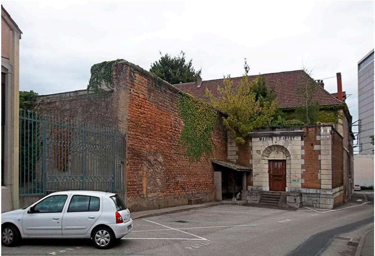
Entrée de la cour de la prison (au fond) et portail menant à la cour nord du palais de justice (à gauche).
