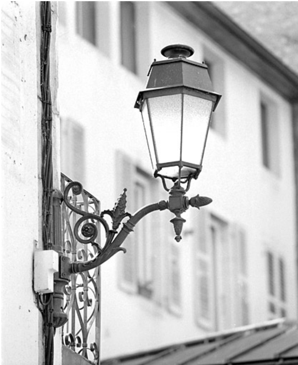
Lampadaire à l'angle sud de l'élévation antérieure.
