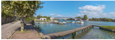
Le port et le pont de Saint-Romain, vus depuis la rive droite. Phot. Thierry Kuntz IVR26_20217100602NUC4A
