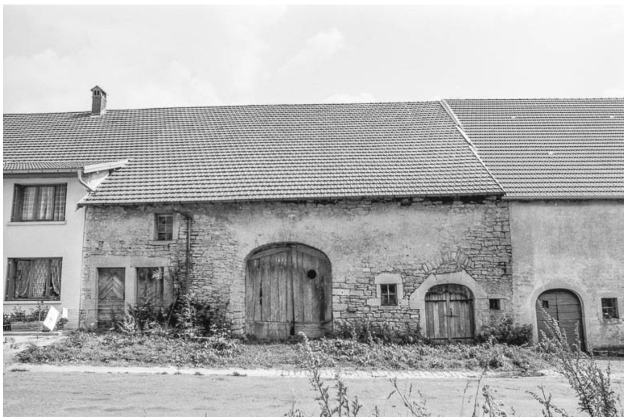
Ferme cadastrée 1951 E1 53 : façade antérieure.
