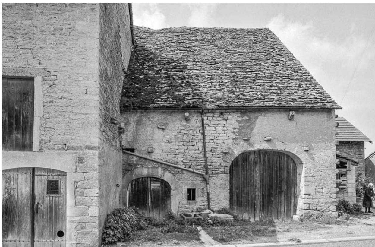
Ferme cadastrée 1951 E1 79 (droite) : façade sur rue.
