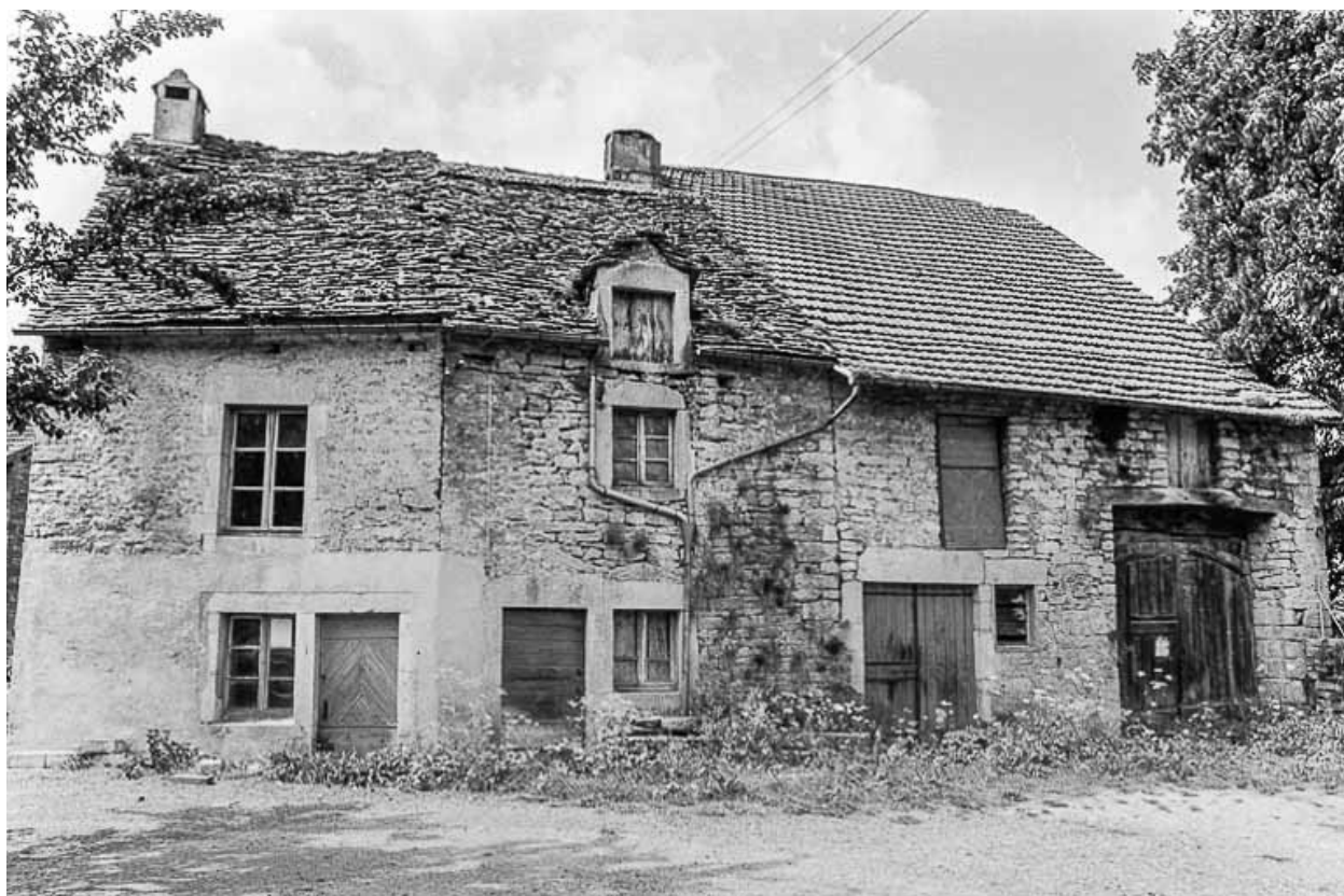
Ferme cadastrée 1951 E1 76 : façade antérieure.
