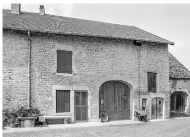
Ferme cadastrée 1951 E1 79 (gauche) : façade antérieure. Phot. Bernard Pontefract IVR43_19763900270Z
