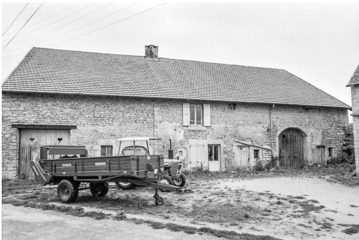
Ferme cadastrée 1951 E1 268 : façade antérieure.
