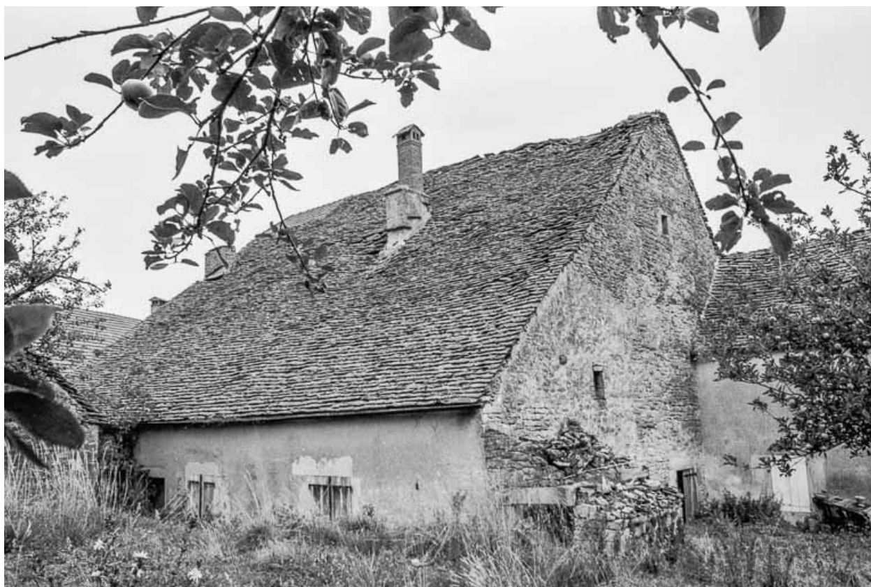
Ferme cadastrée 1951 E1 266 : façade postérieure.
