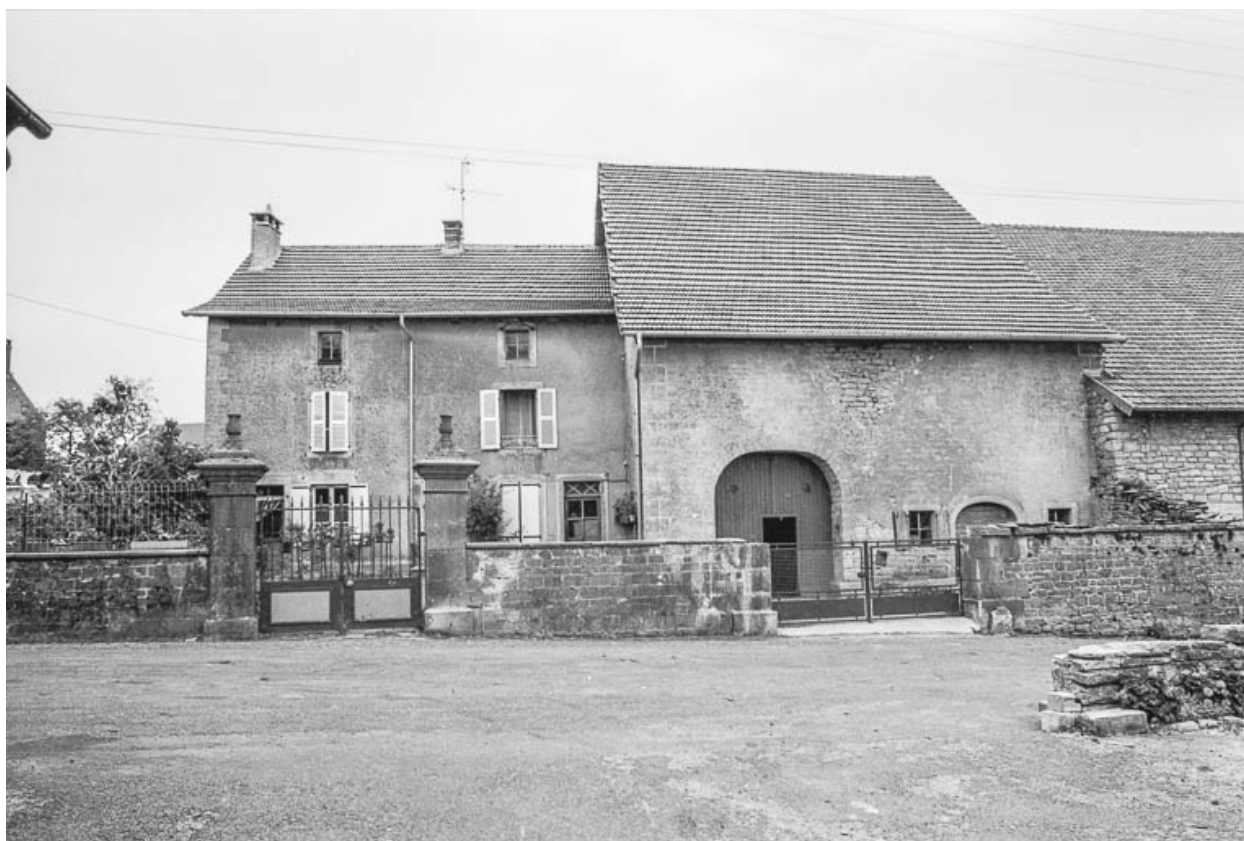
Ferme cadastrée 1951 E1 130 : façade antérieure.
