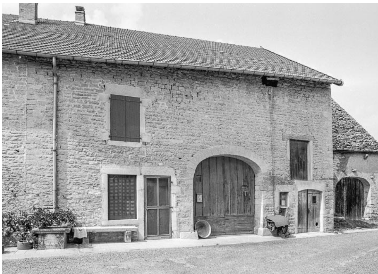
Ferme cadastrée 1951 E1 79 (gauche) : façade antérieure.
