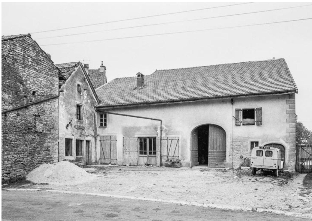
Ferme cadastrée 1951 E1 110 : façade antérieure.
