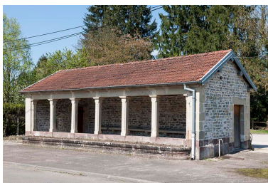
Vue générale, façade antérieure. Phot. Jérôme Mongreville IVR43_20167000397NUC4A
