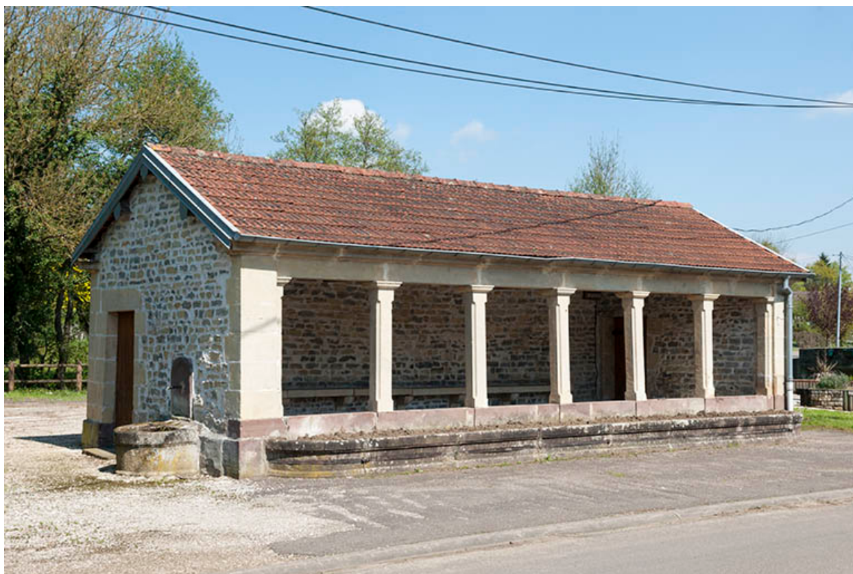
Vue générale depuis le nord.
