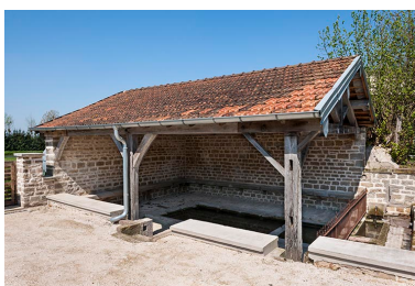
Vue d'ensemble. Phot. Jérôme Mongreville IVR43_20167000356NUC4A
