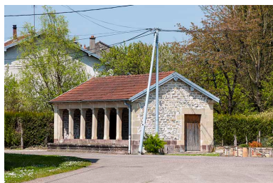
Lavoir-fontaine du colombier. Phot. Jérôme Mongreville IVR43_20167000374NUC4A
