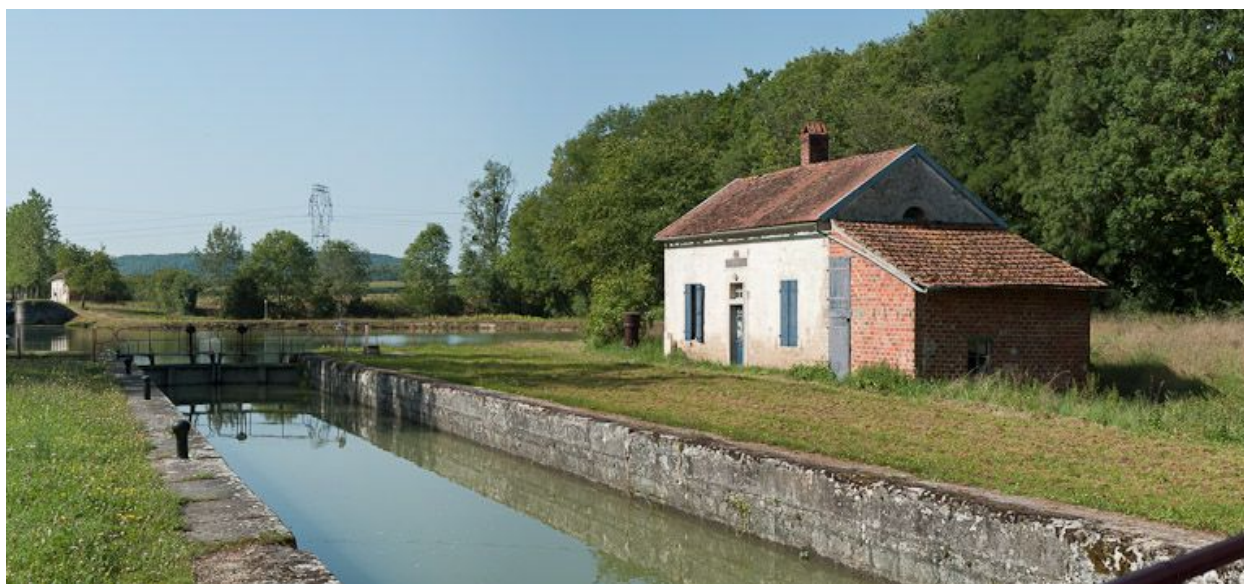
Vue d'ensemble du site d'écluse.
