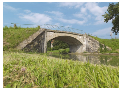
Vue d'amont. Phot. Thierry Kuntz
