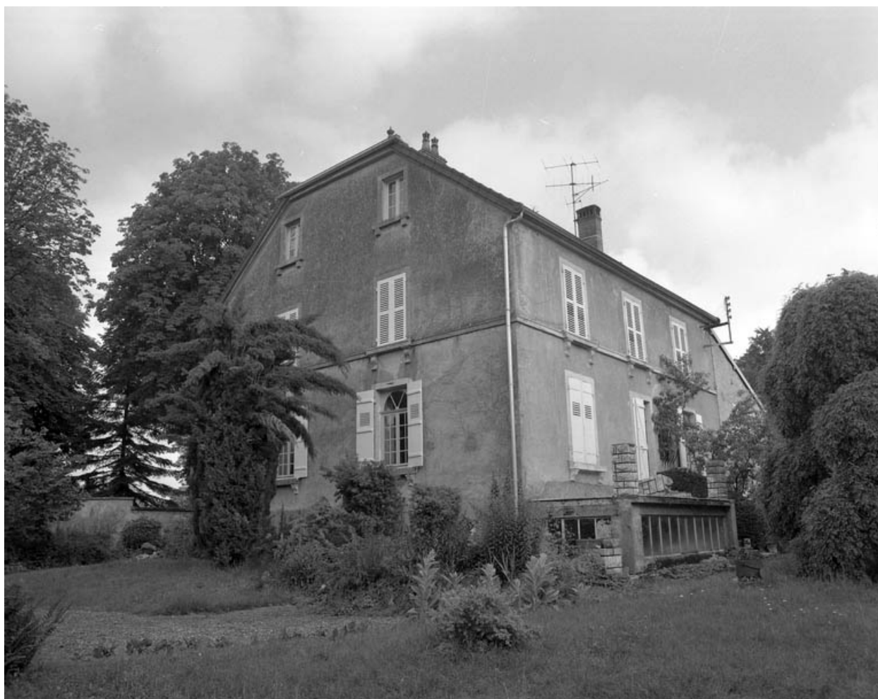
Façades postérieures et latérales droite.
