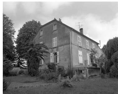
Façades postérieures et latérales droite.
