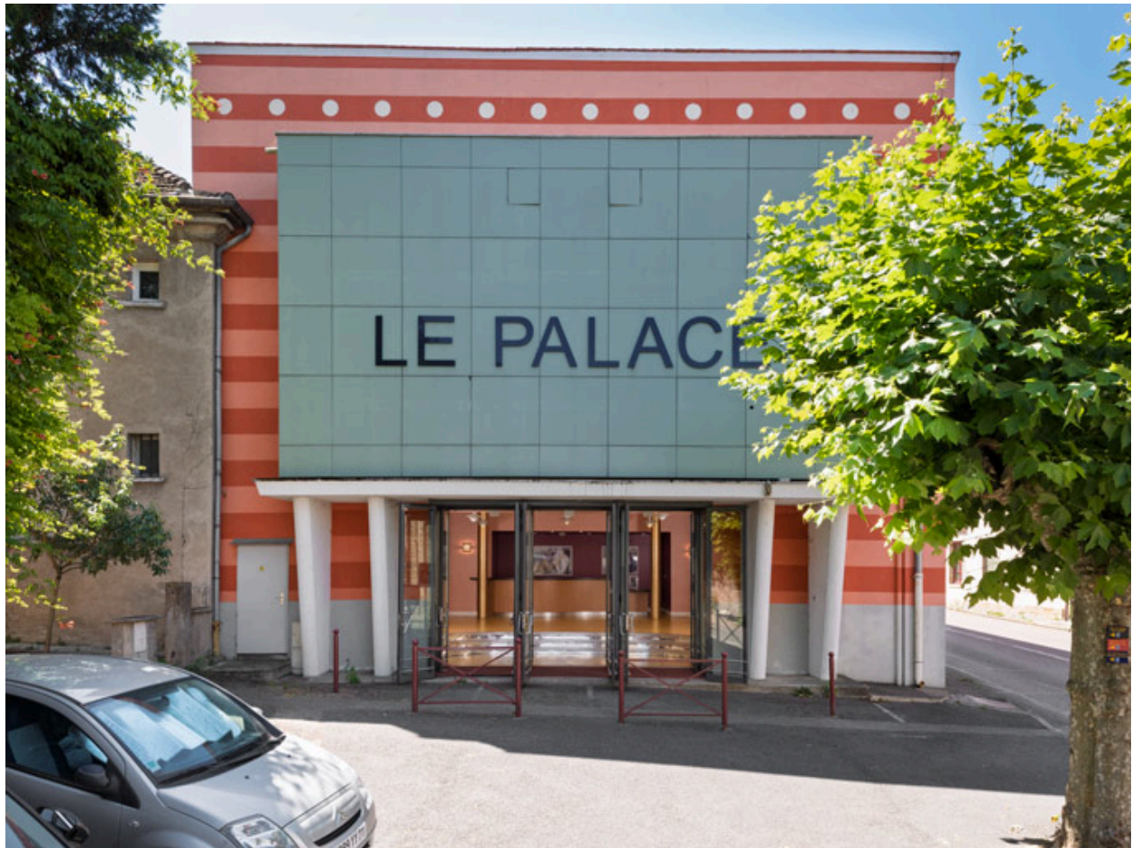
Salle de spectacle : façade antérieure.
