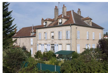
Façade postérieure. Phot. Jérôme Mongreville IVR43_20127000644NUC4A
