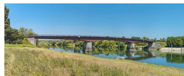
Le pont de Bragny vu d'amont. Phot. Thierry Kuntz IVR26_20207100219NUC4A
