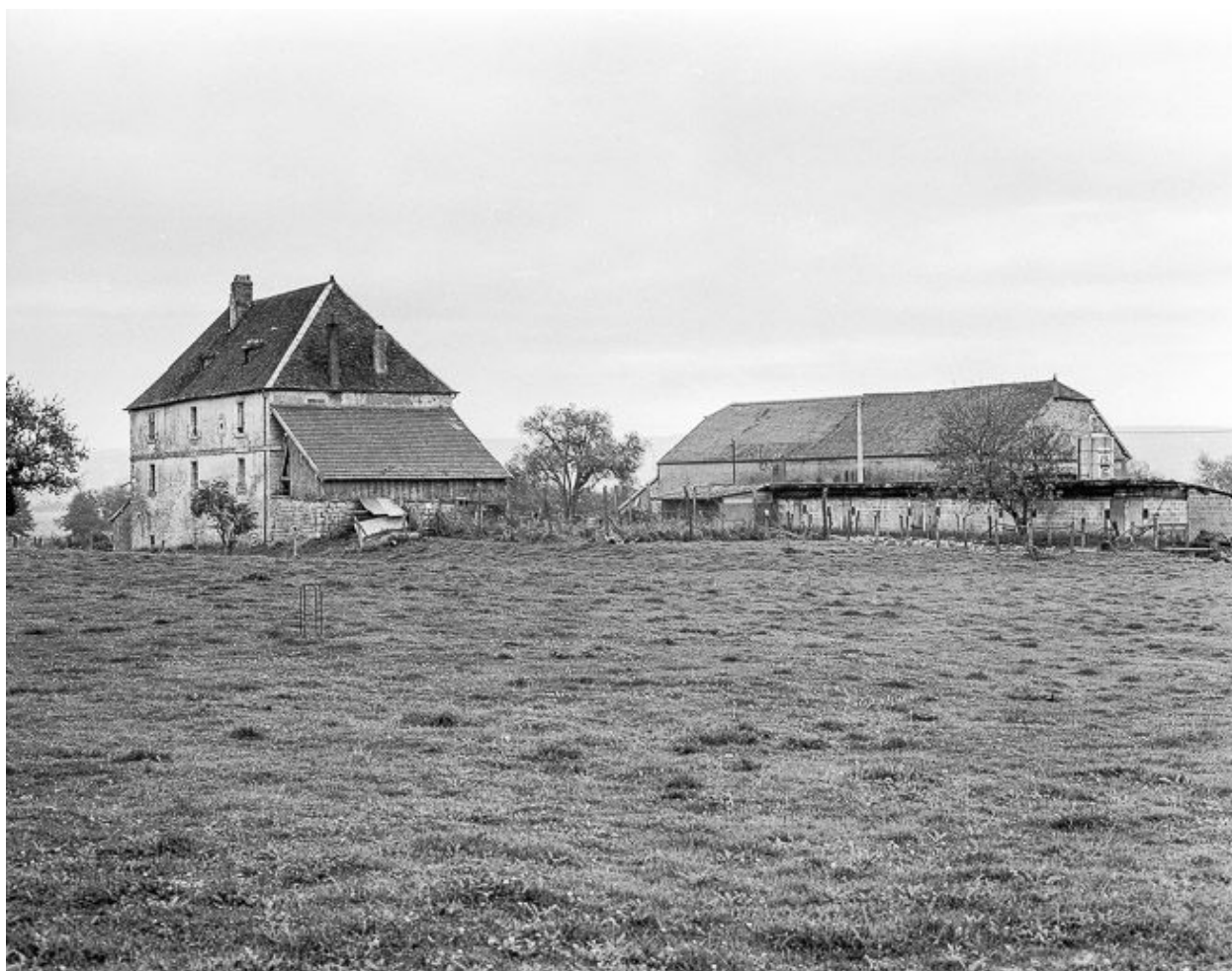
Façades postérieure et latérale droite.
