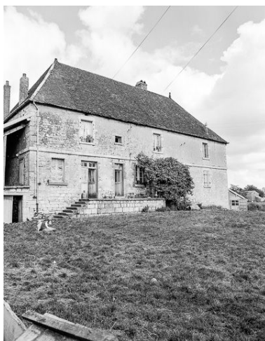
Partie habitation : façade antérieure. Phot. Dominique Dominguez IVR43_19807000225X
