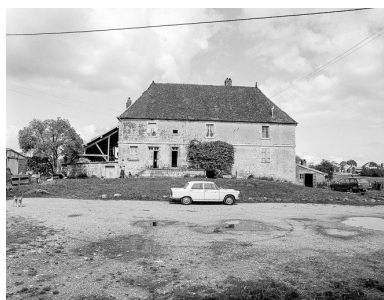
Partie habitation : vue de face. Phot. Dominique Dominguez IVR43_19807000224X
