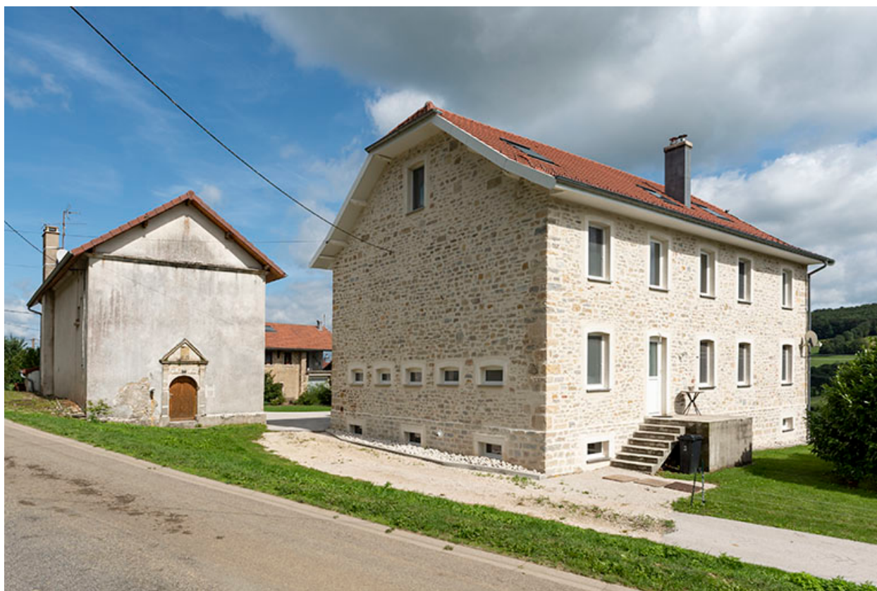
Façades postérieure et latérale droite.
