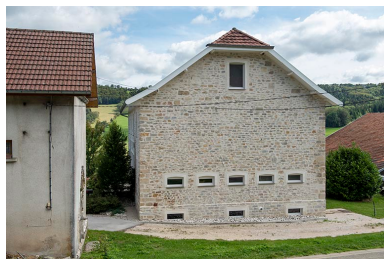
Façade latérale droite. Phot. Sonia Dourlot IVR43_20192500908NUC4A
