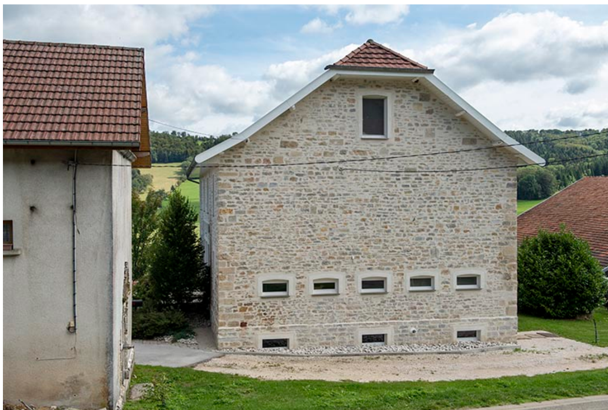
Façade latérale droite.
