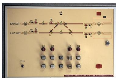
Tableau de commande et de contrôle optique.
