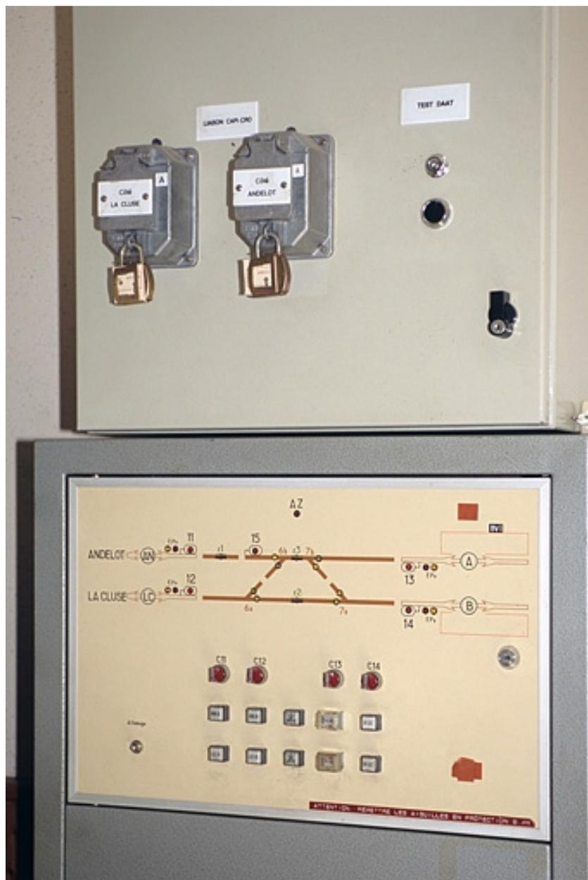
Vue d'ensemble. L'armoire surmontant celle du PRS renferme le dispositif d'arrêt automatique des trains (DAAT), système indépendant du poste tout relais. L'armoire surmontant celle du PRS renferme le dispositif d'arrêt automatique des trains (DAAT), système indépendant du poste tout relais.
