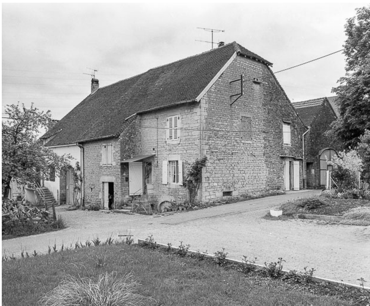
Façades antérieure et latérale droite.
