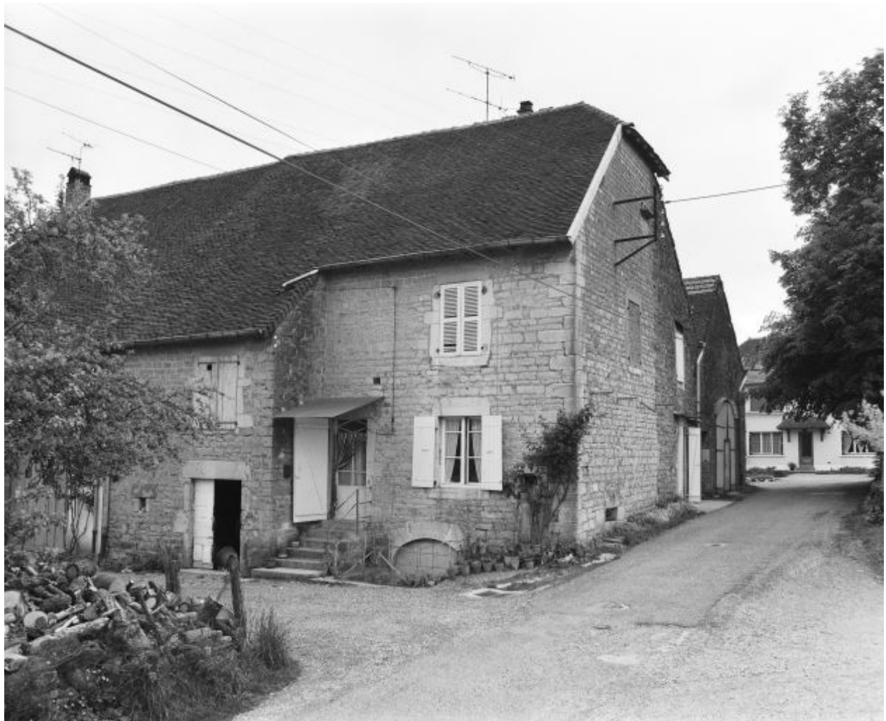
Façades antérieure et latérale droite.
