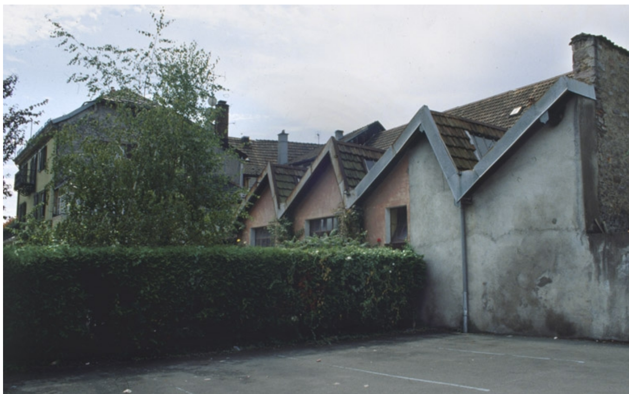
L'atelier de fabrication depuis le nord.
