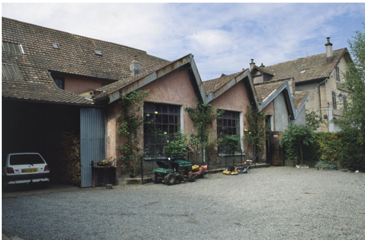
Sheds de l'atelier de fabrication.
