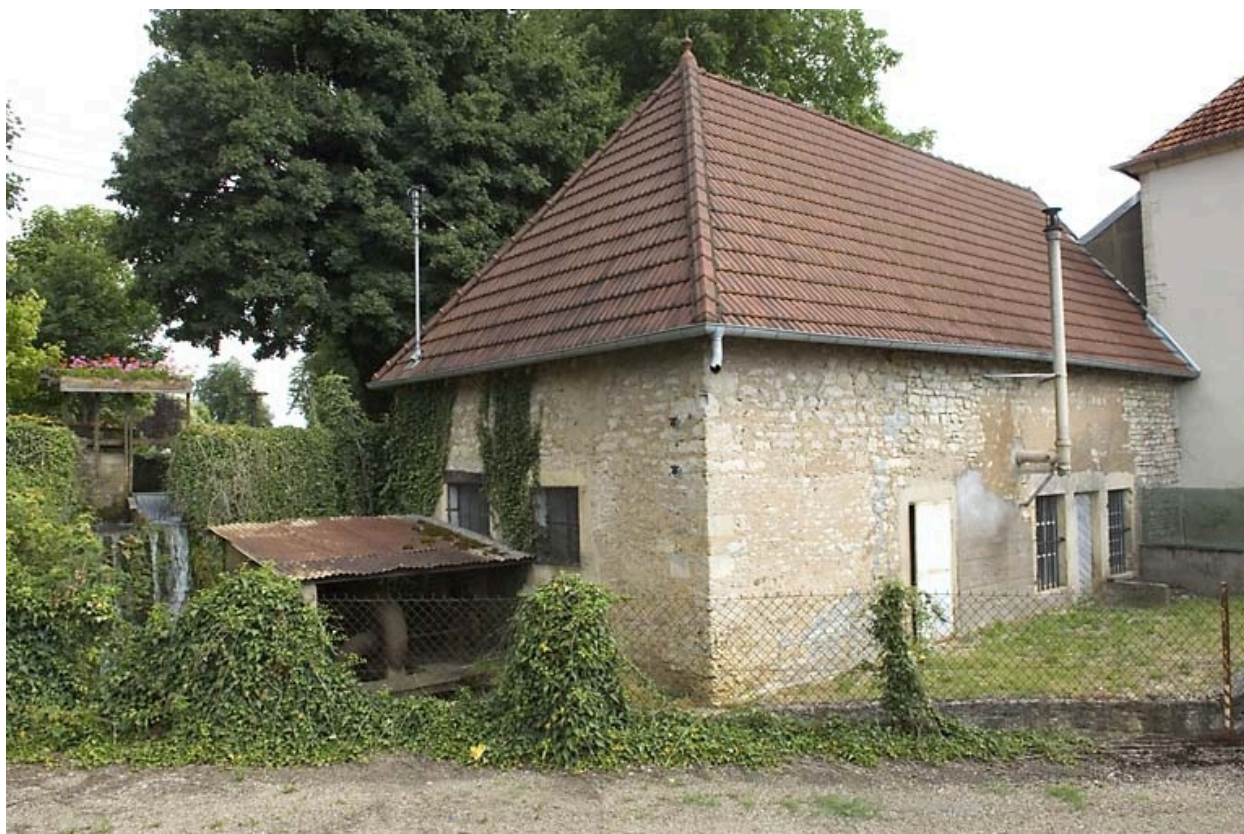
Local de la turbine et atelier.
