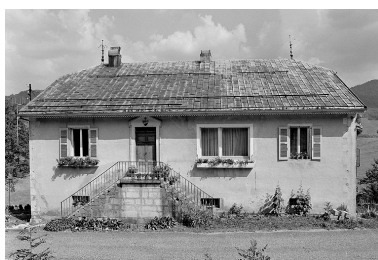
Les Bouchoux : maison de boucher puis de douaniers, située au lieu-dit La Serra. Phot. Jérôme Mongreville IVR43_19943900821X
