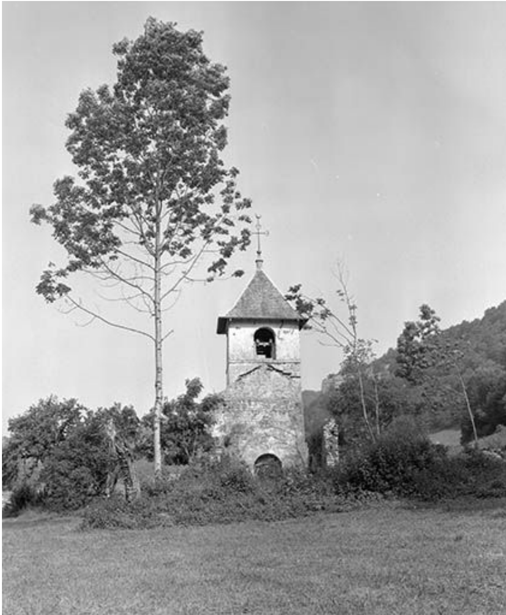
Tour du clocher depuis l'est.
