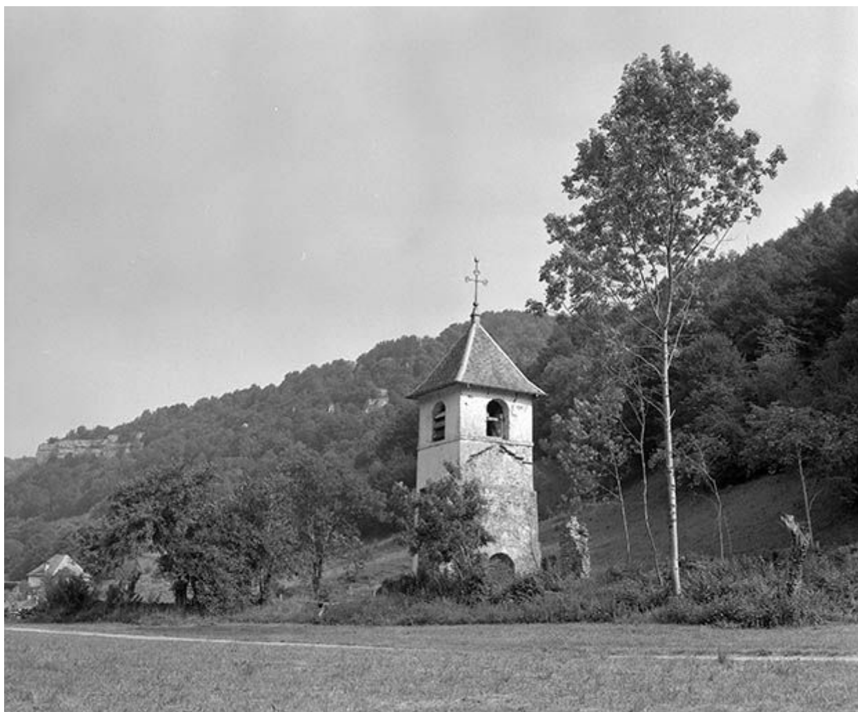
Tour du clocher depuis le sud-est.
