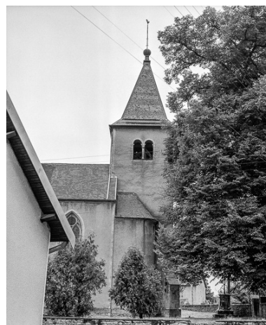
Clocher : façade gauche. Phot. Yves Sancey IVR43_19767000675X
