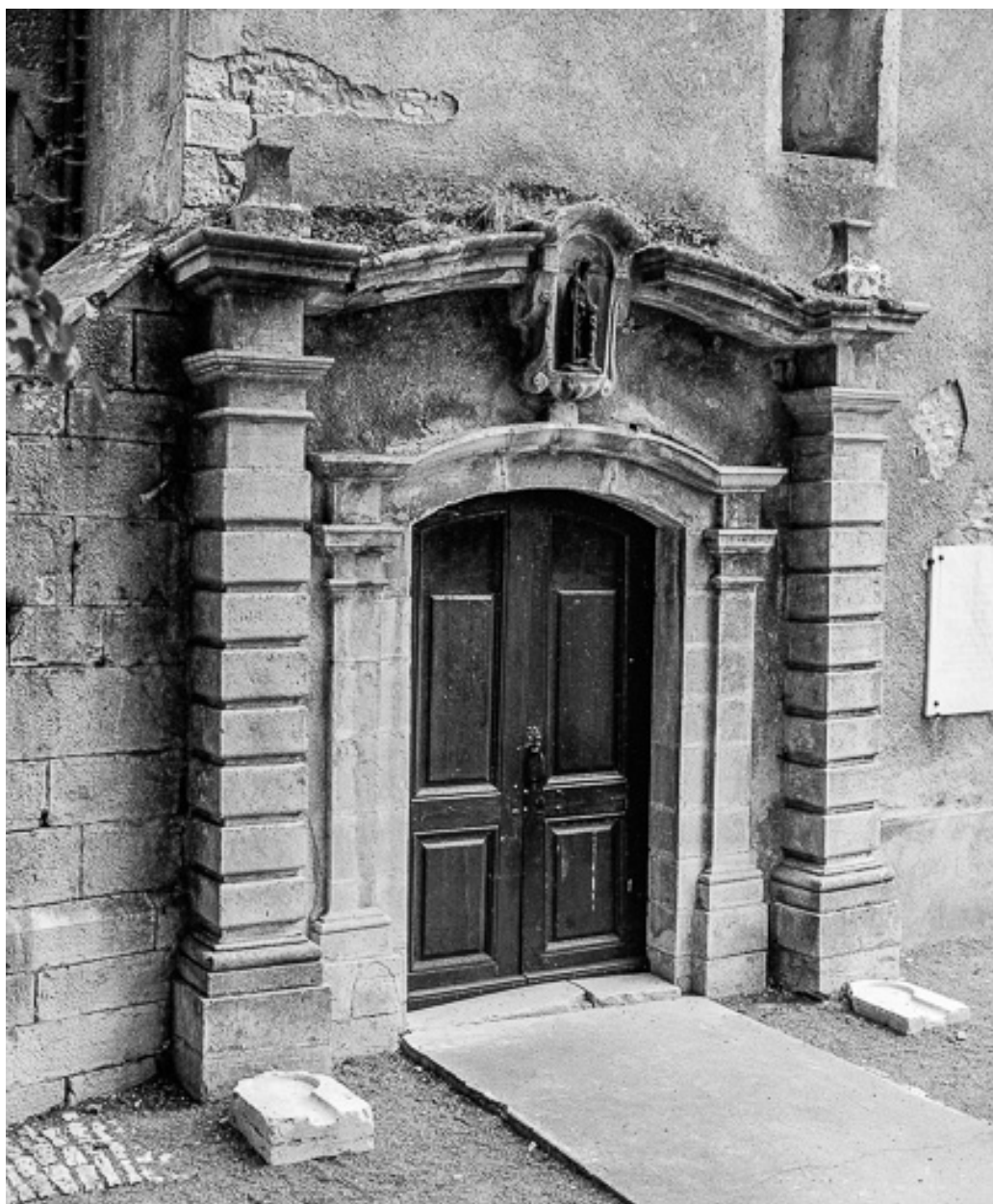
Portail d'entrée vue de trois quarts gauche.
