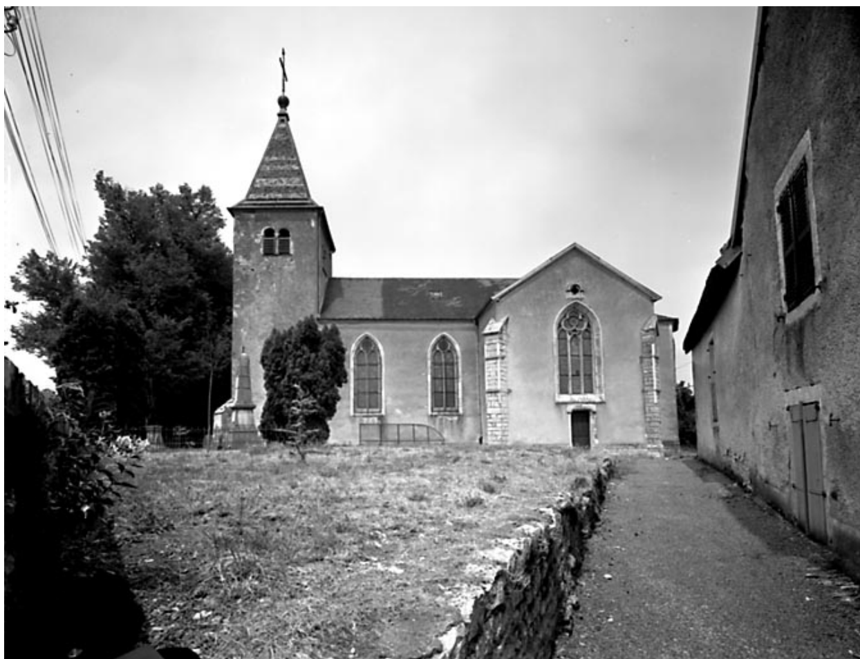
Façade latérale droite.
