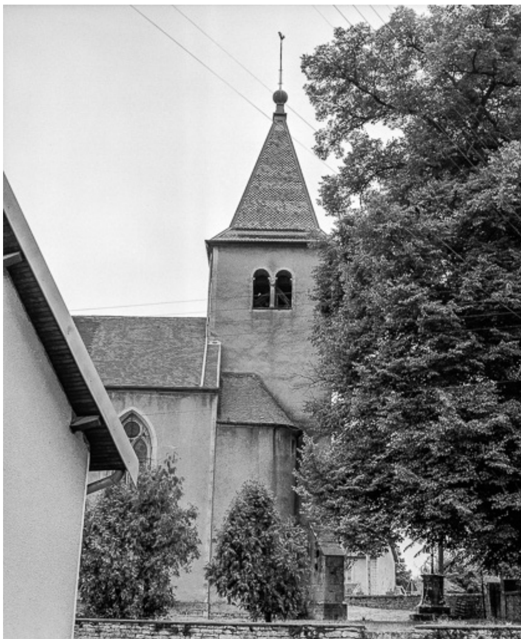
Clocher : façade gauche.
