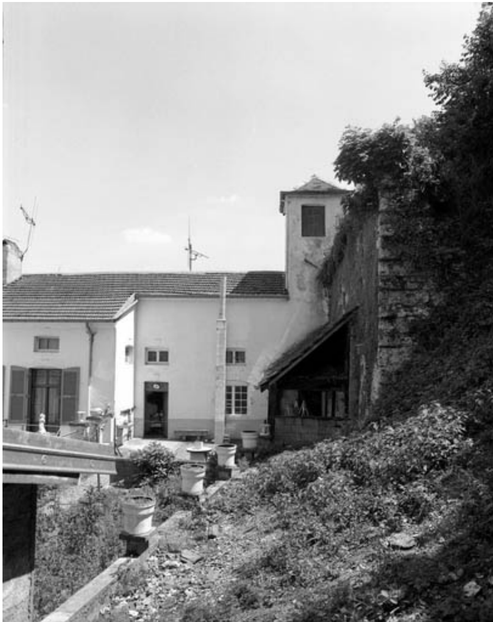
Détail : extrémité de l'aile sur cour.
