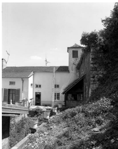
Détail : extrémité de l'aile sur cour. Phot. Yves Sancey IVR43_19897000381X
