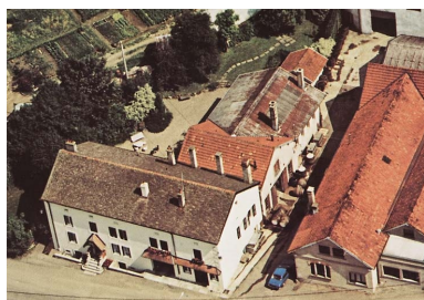
Vue aérienne. Phot. Jérôme Mongreville IVR43_20077000022NUCA
