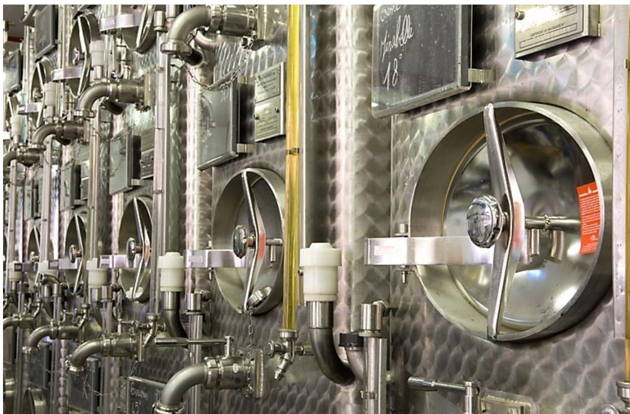
Chai. Détail des cuves.
