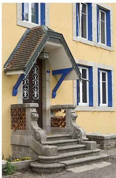
Logement principal. Le perron. Phot. Jérôme Mongreville IVR43_20077000229NUCA
