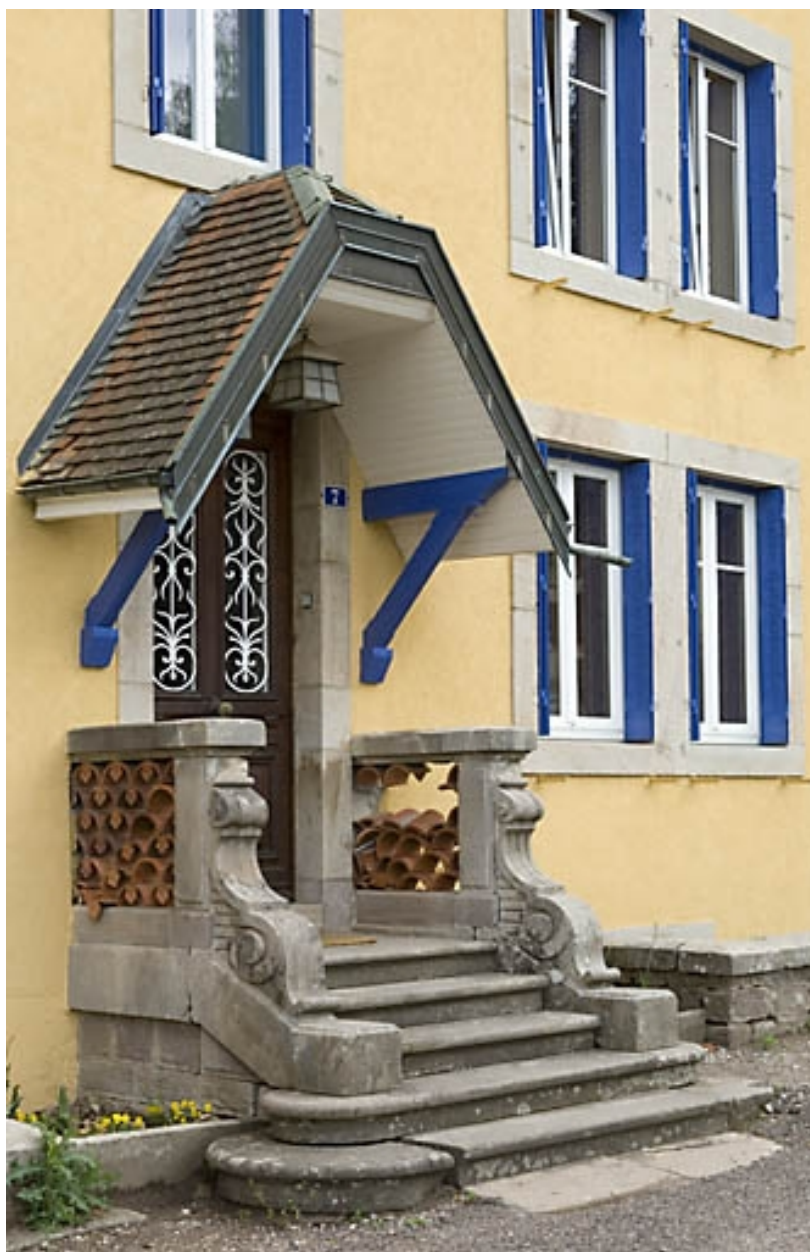
Logement principal. Le perron.
