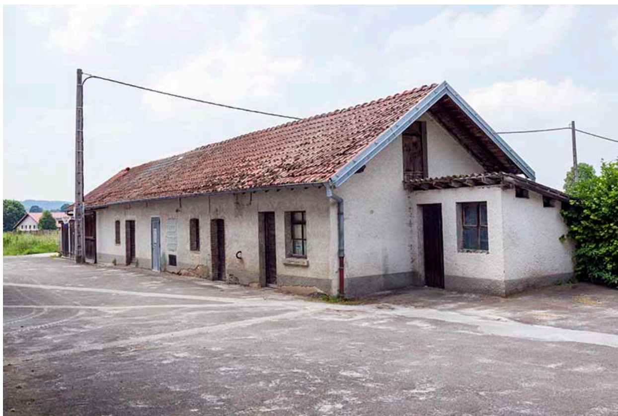
Etable, transformateur et garage.
