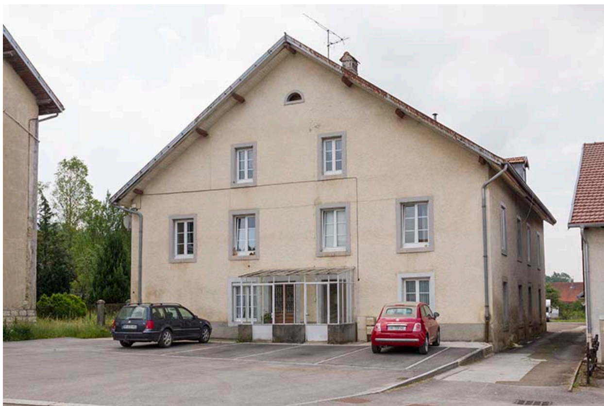
Le logement patronal.
