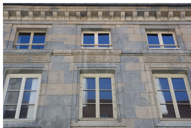
Détail des fenêtres des deuxième et troisième étages. Phot. Yves Sancey IVR43_20072500277NUCA
