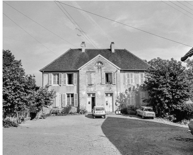
Façade antérieure. Phot. Dominique Dominguez IVR43_19803900043X
