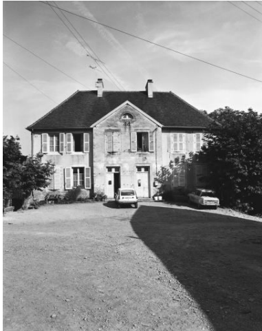
Façade antérieure. Phot. Dominique Dominguez IVR43_19803900044X
