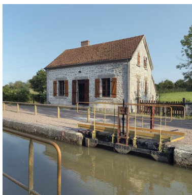
La maison éclusière, vue de 3/4 avant. Phot. Thierry Kuntz IVR26_20135800239NUC4A
