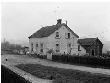
Vue d'ensemble de la maison éclusière en 1975. Phot. non renseigné IVR26_19755800573V
