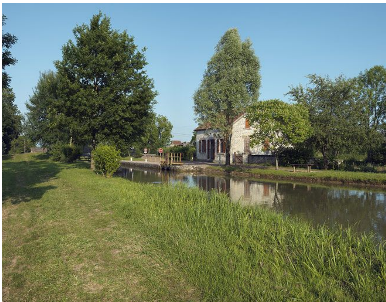
Le site d'écluse, d'amont.
