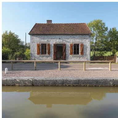
La maison éclusière : vue de face.
