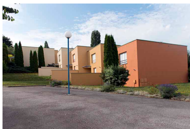
Façade antérieure nord-est des logements. Phot. Mary Ruffinoni IVR43_20137000537NUC4A
