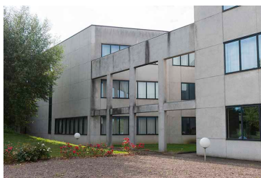
Détail de la façade nord. Phot. Mary Ruffinoni IVR43_20137000544NUC4A
