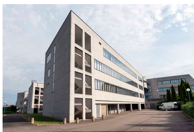
Angle sud, façades sud-est et sud-ouest Phot. Mary Ruffinoni IVR43_20137000539NUC4A
