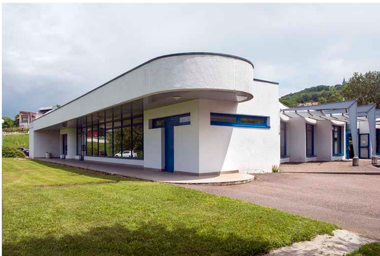
Angle sud-ouest de la restauration.
