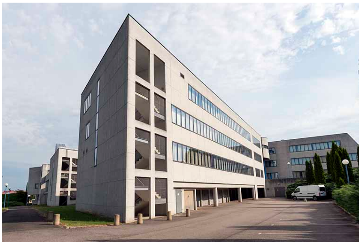
Angle sud, façades sud-est et sud-ouest
