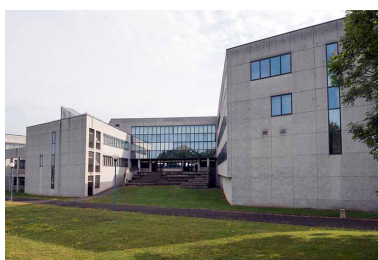
Détail d'un préau de la façade sud. Phot. Mary Ruffinoni IVR43_20137000540NUC4A
