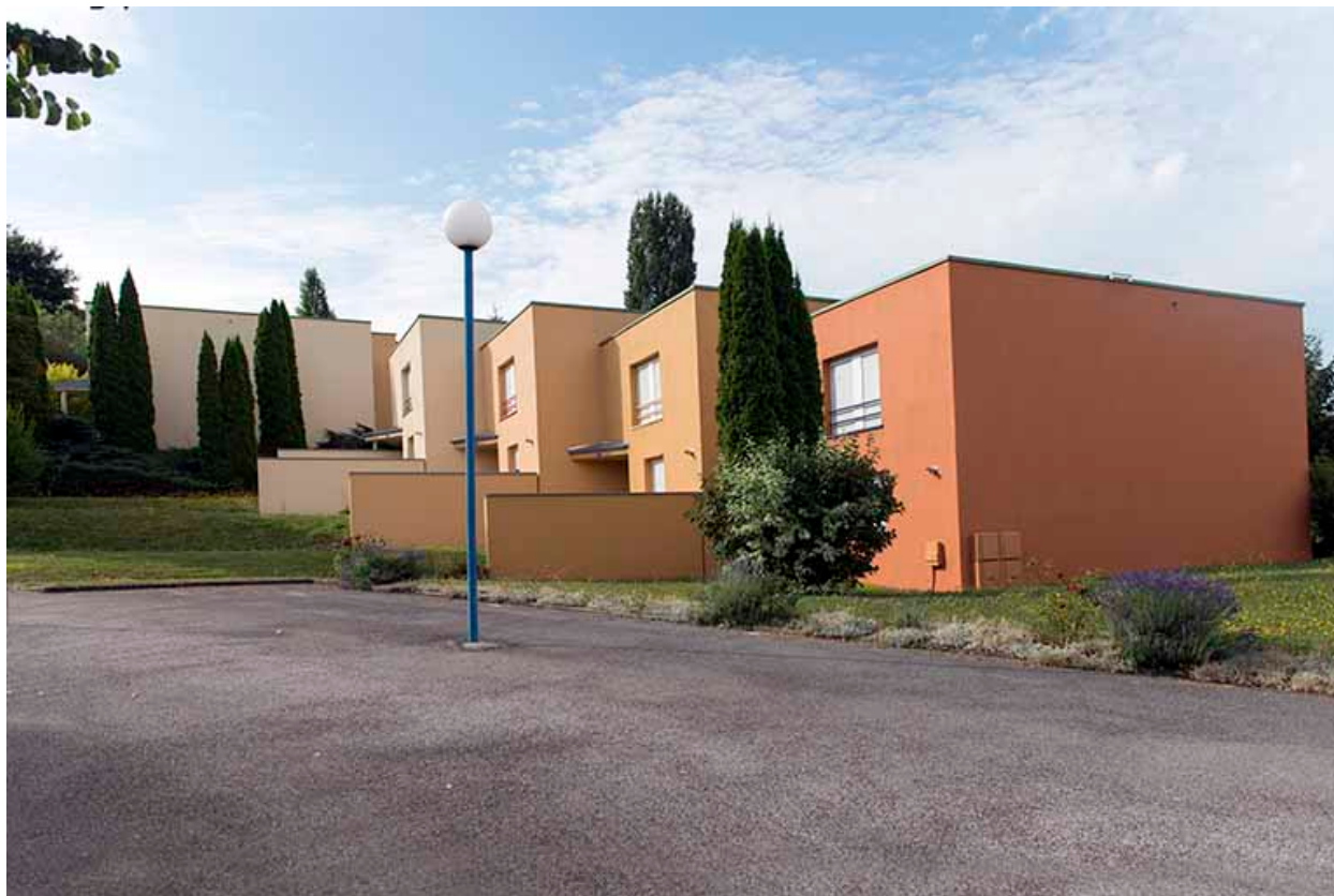
Façade antérieure nord-est des logements.
