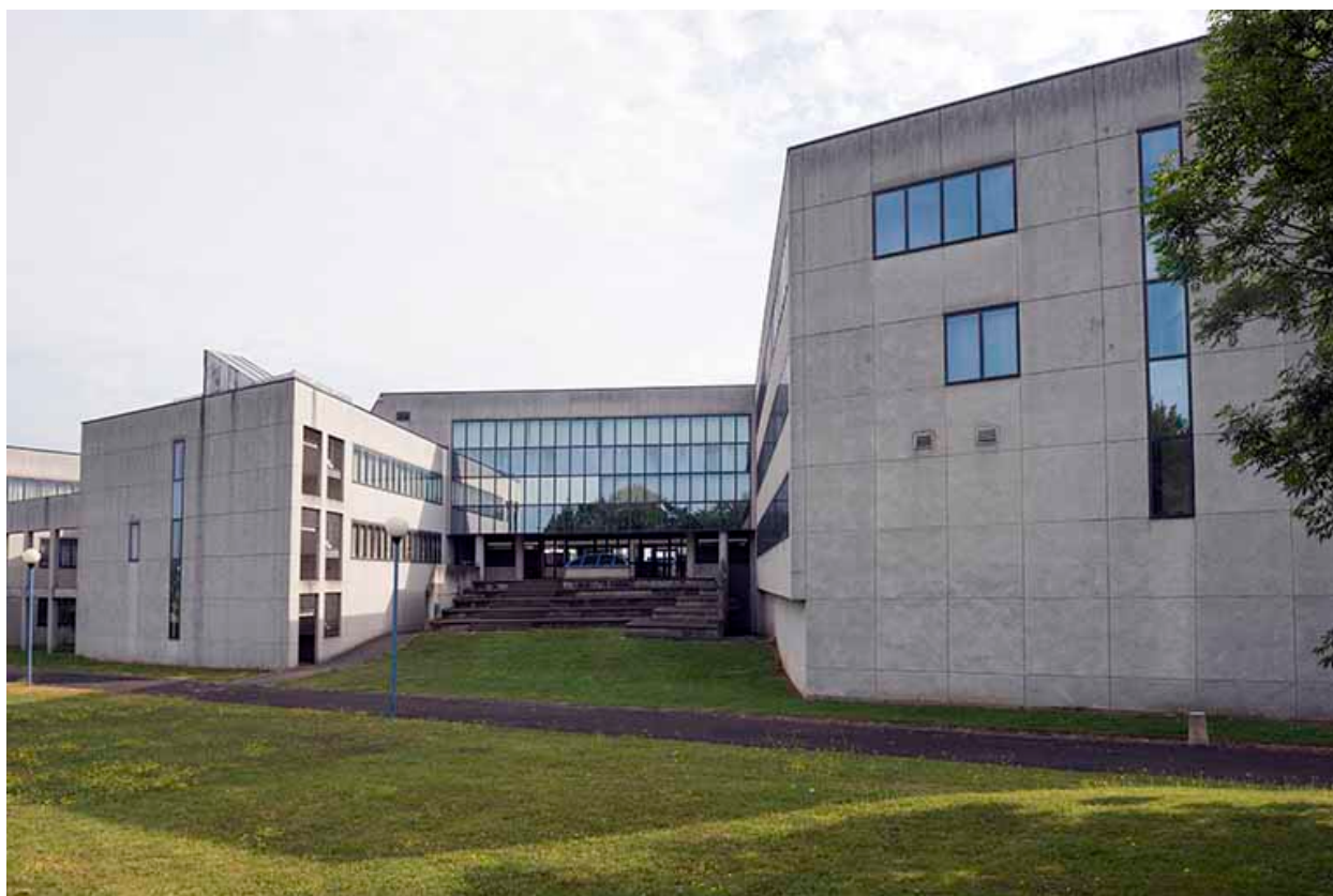
Détail d'un préau de la façade sud.
