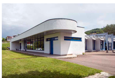
Angle sud-ouest de la restauration. Phot. Mary Ruffinoni IVR43_20137000526NUC4A
