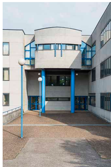
Détail de la façade sud-est, entrée postérieure.
