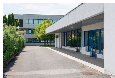
Détail de la façade est de la restauration. Phot. Mary Ruffinoni IVR43_20137000528NUC4A
