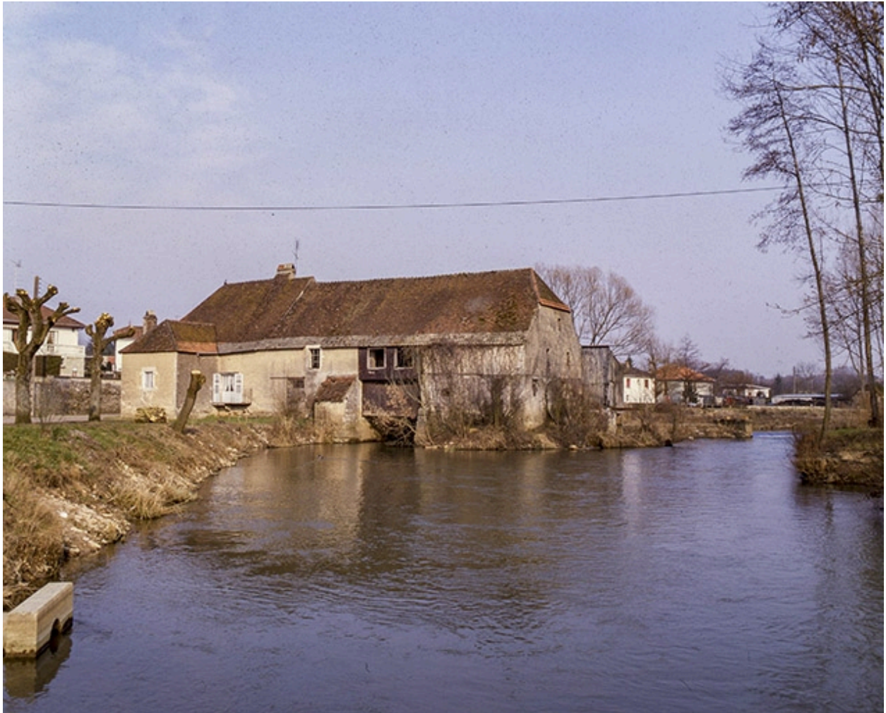
Vue d'ensemble depuis le pont.
