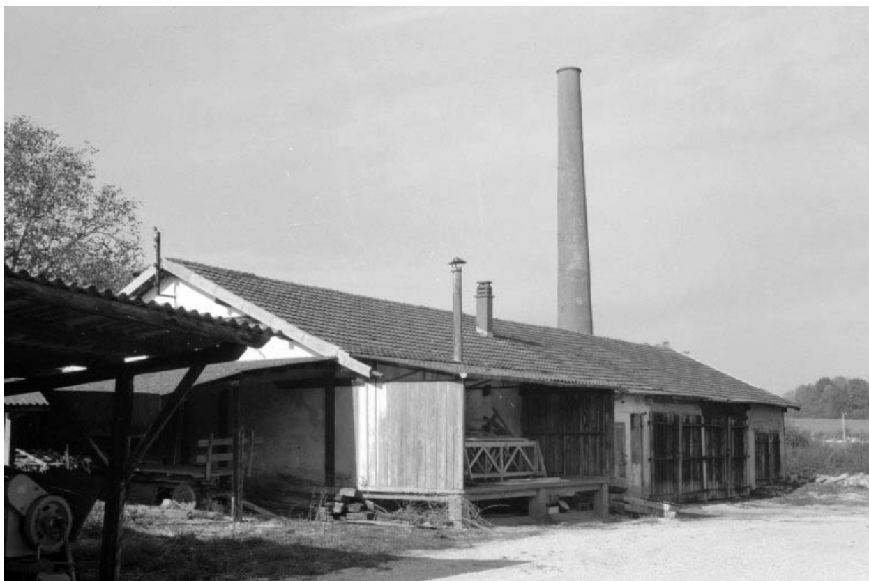
Hangar (C), remise (B) et cheminée d'usine.
