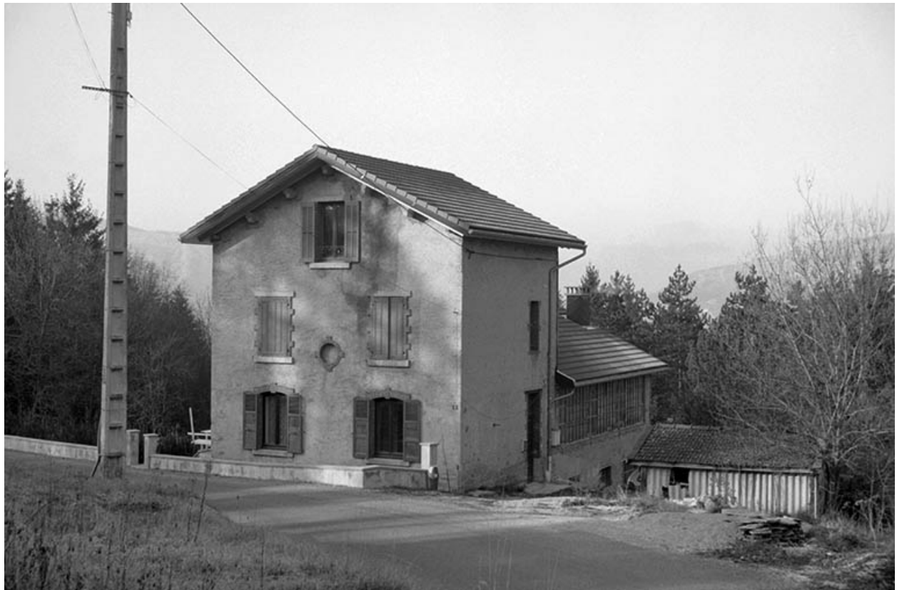
Façades antérieure et latérale droite.
