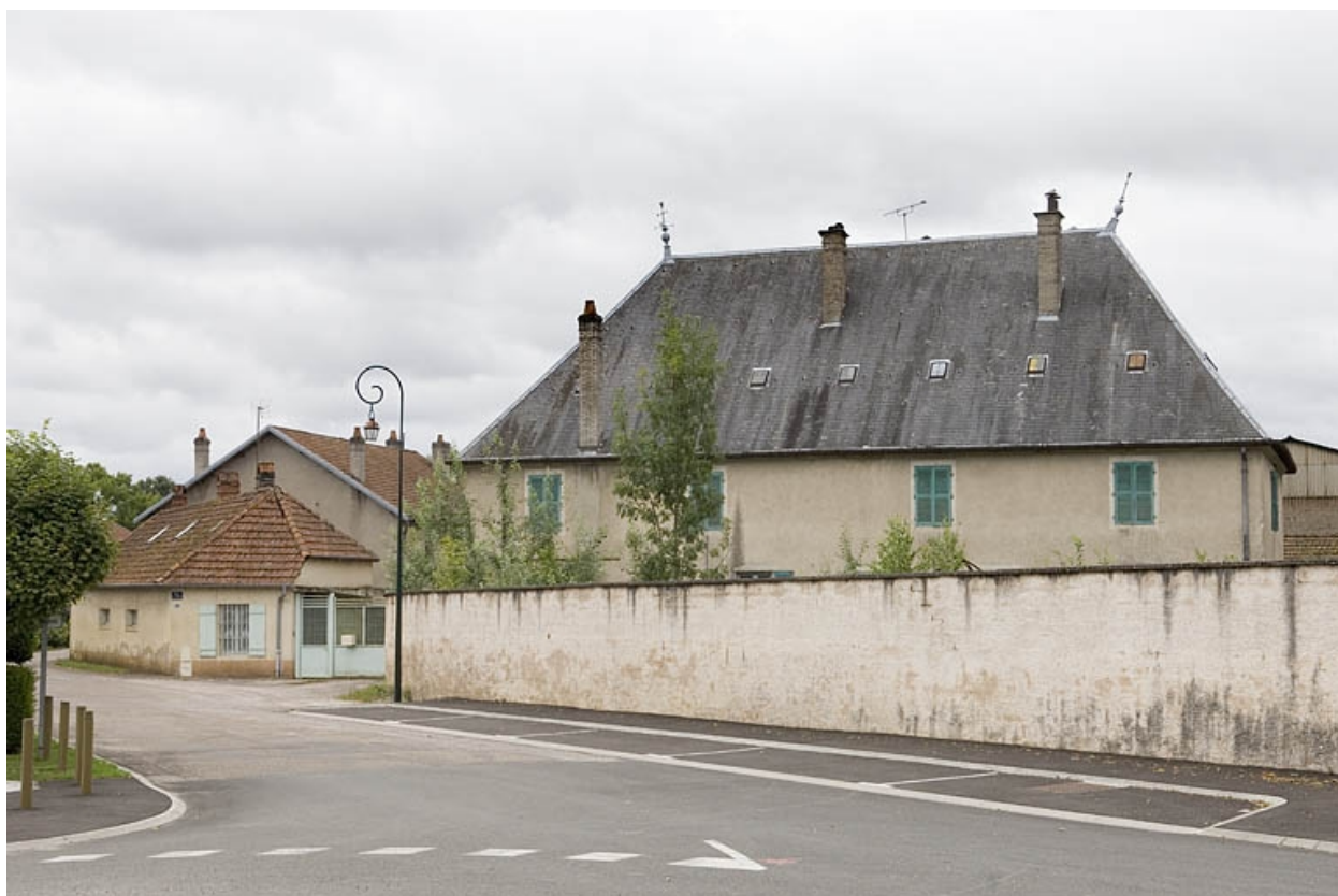
Conciergerie et logement patronal depuis le nord.
