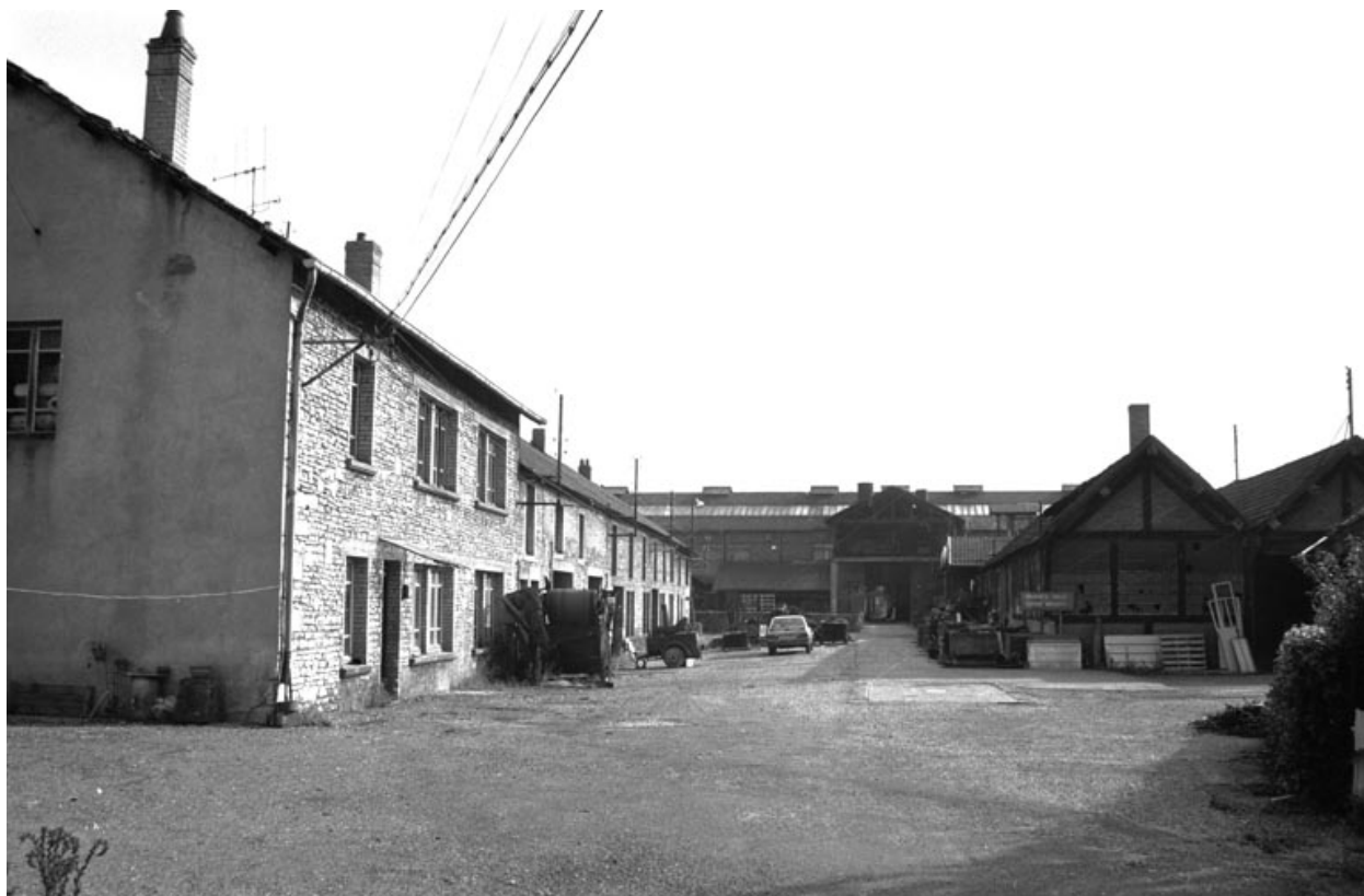
Vue d'ensemble depuis l'entrée en 1987.
