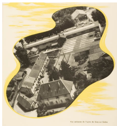
Vue aérienne de l'usine de Sceaux-sur-Saône. Phot. Jérôme Mongreville IVR43_20097000079NUC2A
