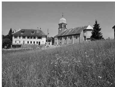
Vue générale de la mairie- école et de l'église.
