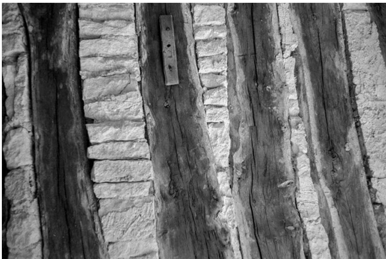
Intérieur des parties agricoles : le plafond.
