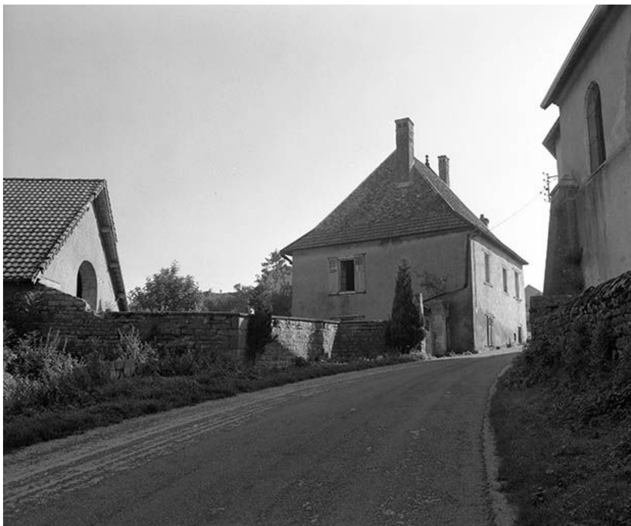
Vue d'ensemble depuis la rue.
