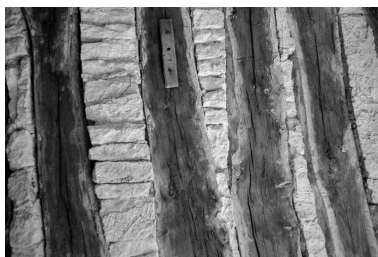
Intérieur des parties agricoles : le plafond. Phot. Gilbert Poinot IVR43_19762500809Z
