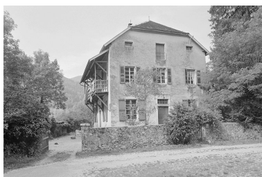
Demeure de notable, dite le château des Granges. Phot. Jérôme Mongreville IVR43_19973900835X
