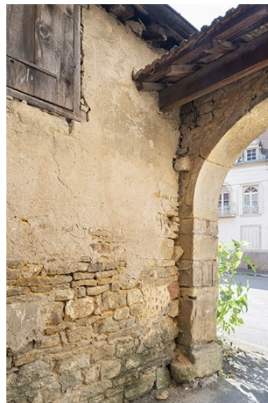
Détail de maçonnerie depuis la cour. Phot. Jérôme Mongreville IVR43_20217000580NUC4A
