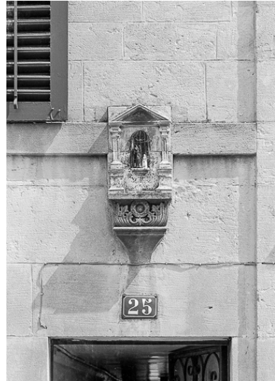
Détail : niche au-dessus de la porte. Phot. Yves Sancey IVR43_19802500302X
