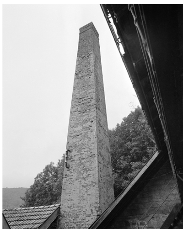
Cheminée de la chaufferie. Phot. Yves Sancey IVR43_19999000265X
