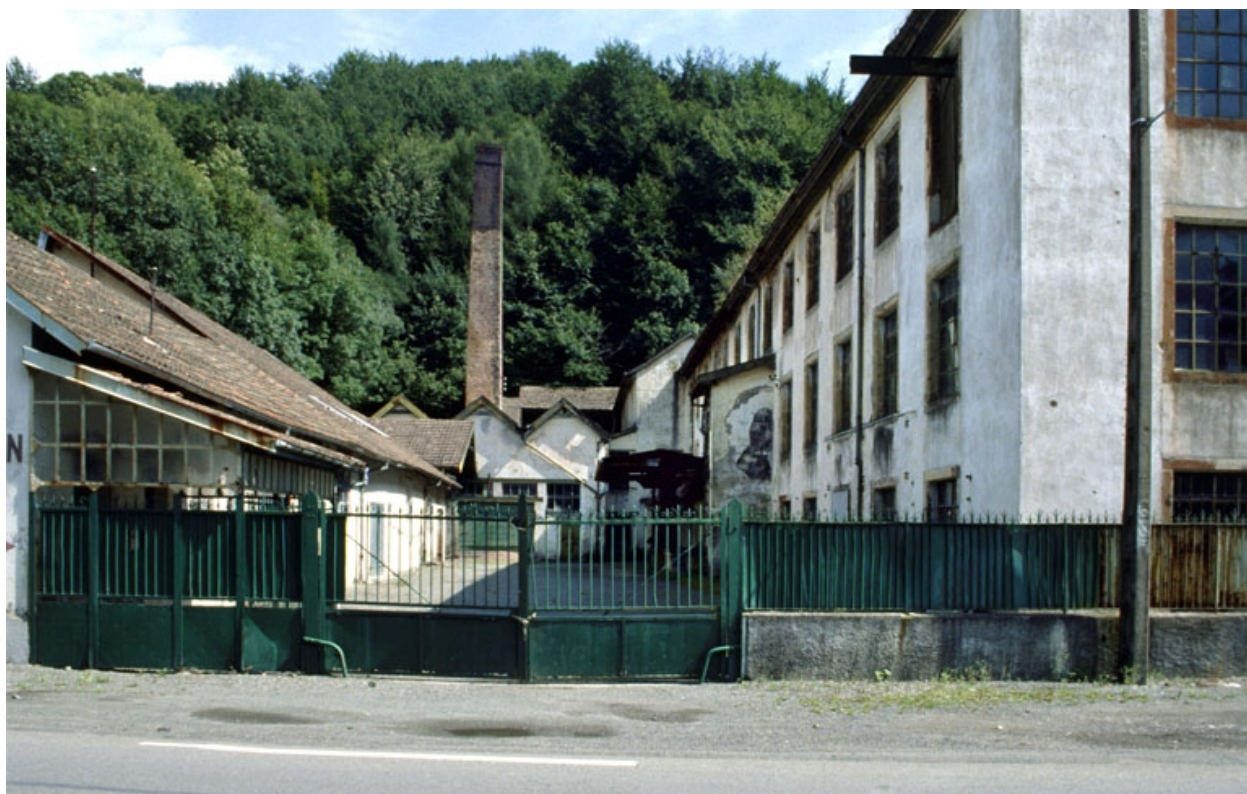
La cour de l'usine.
