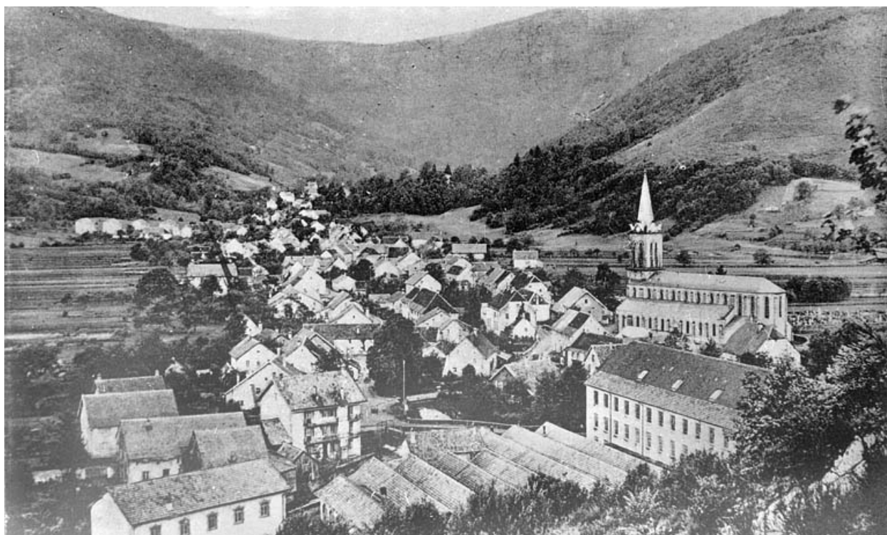
Le Puix. Vue générale.
