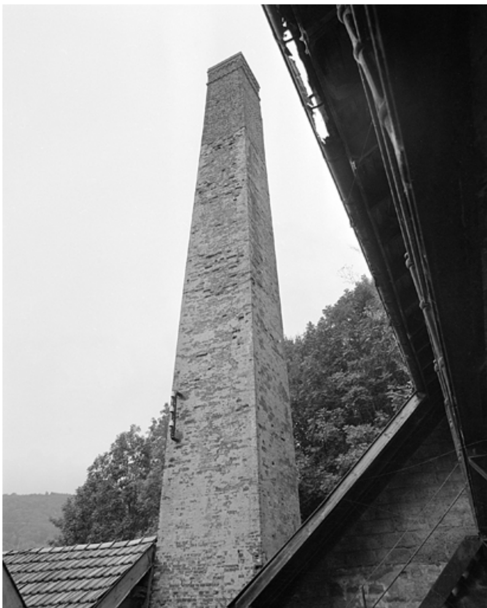
Cheminée de la chaufferie.
