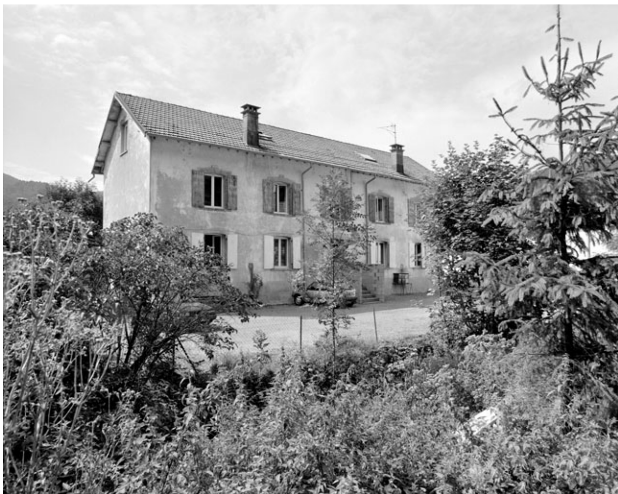
Façade antérieure du logement d'ouvriers.
