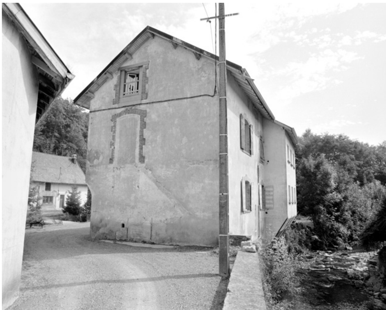
Logement d'ouvriers sur la rivière.
