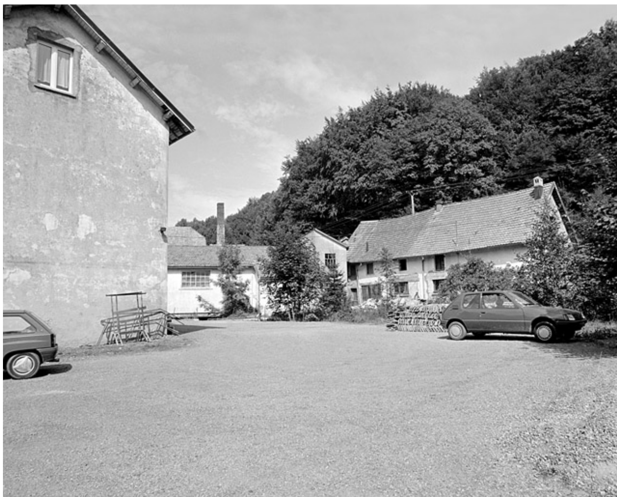
Logements d'ouvriers depuis le sud.
