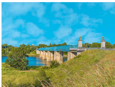
Vue d'ensemble du pont, d'aval. Phot. Thierry Kuntz IVR26_20207100327NUC4A
