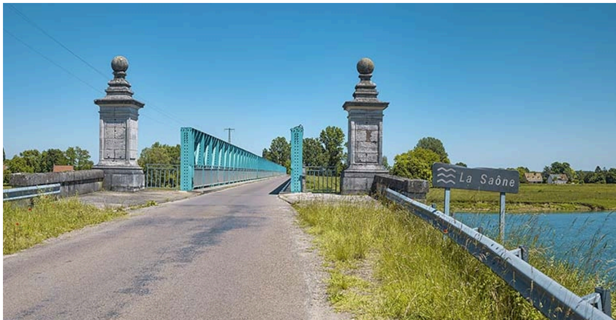
Entrée du pont.
