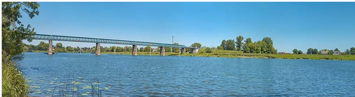
Vue d'ensemble d'amont.
