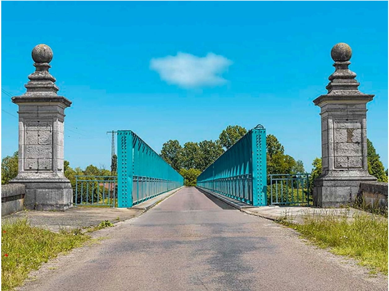
Entrée du pont.
