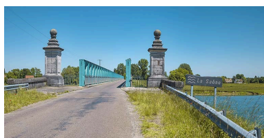
Entrée du pont. Phot. Thierry Kuntz IVR26_20207100320NUC4A
