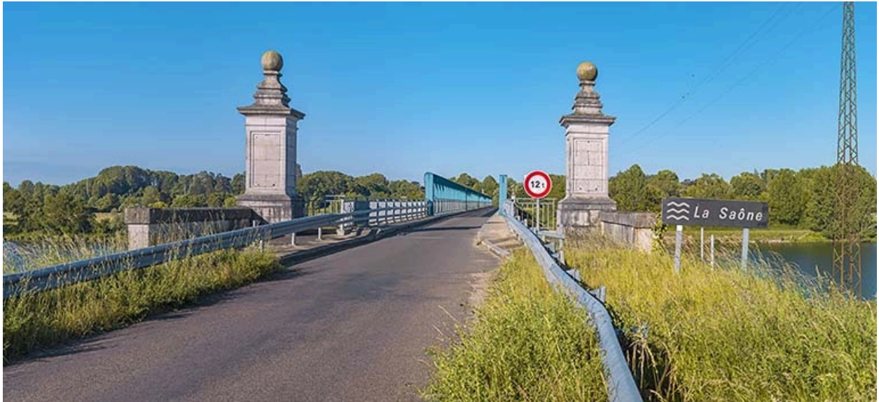
Entrée du pont.
