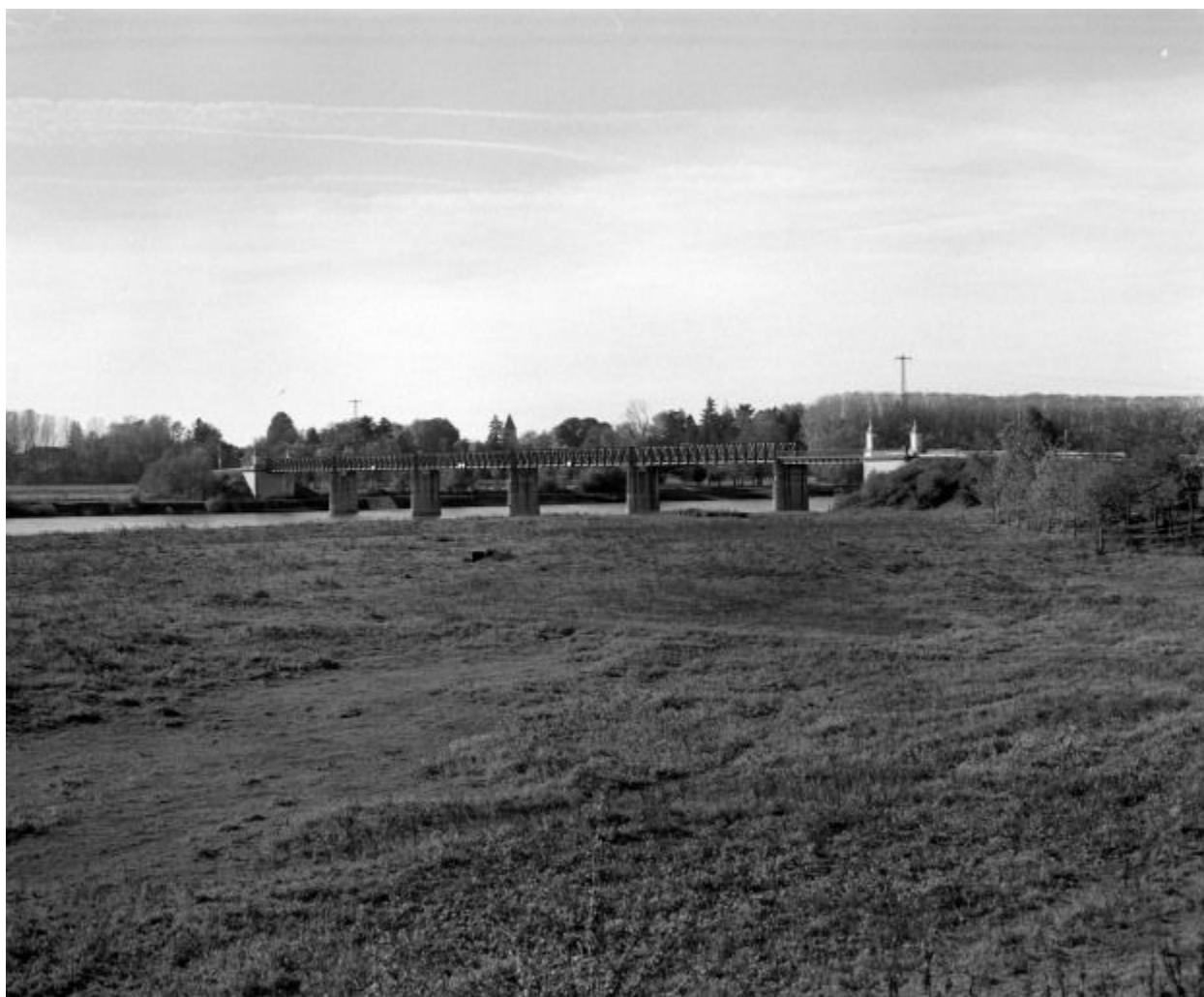
Vue d'ensemble du pont en 1986.
