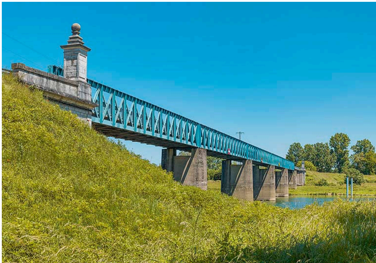
Vue d'ensemble du pont.
