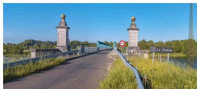
Entrée du pont. Phot. Thierry Kuntz IVR26_20207100323NUC4A
