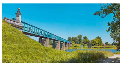
Vue d'ensemble du pont. Phot. Thierry Kuntz IVR26_20207100317NUC4A
