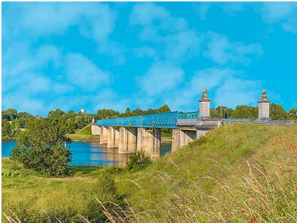
Vue d'ensemble du pont, d'aval.
