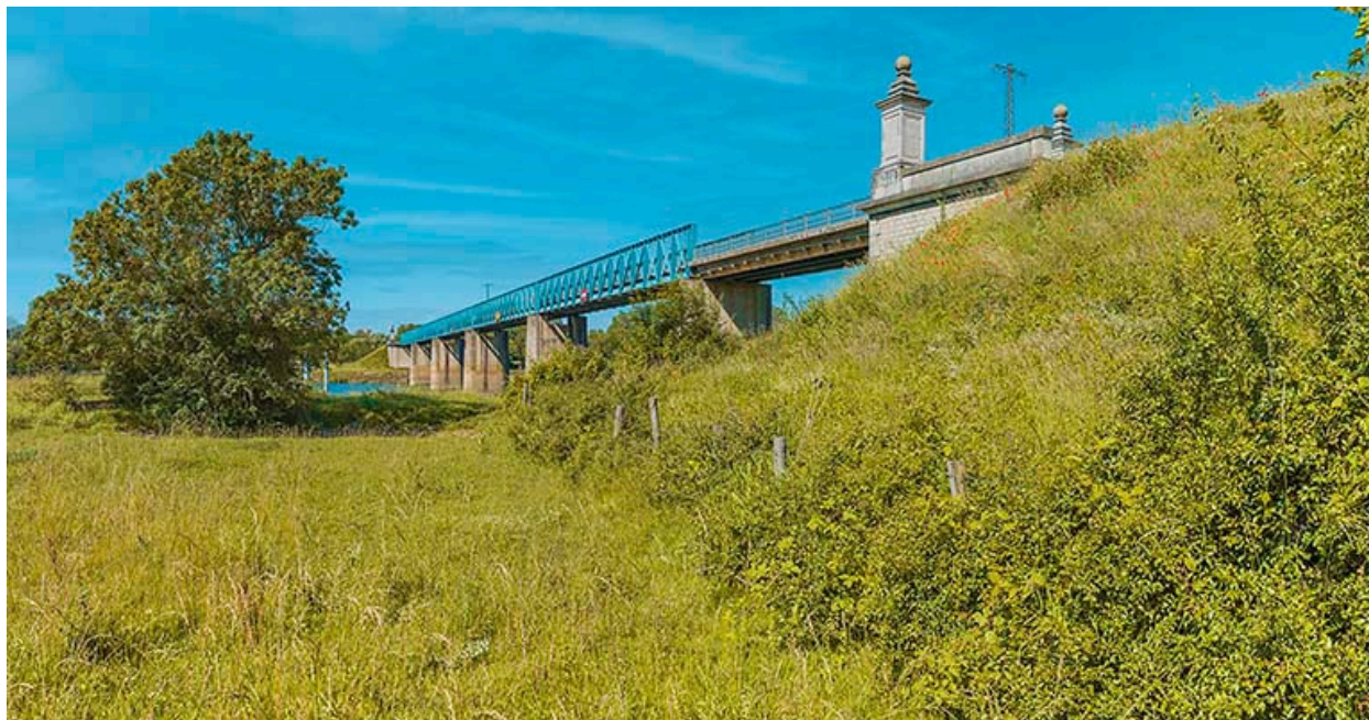
Vue d'ensemble du pont.
