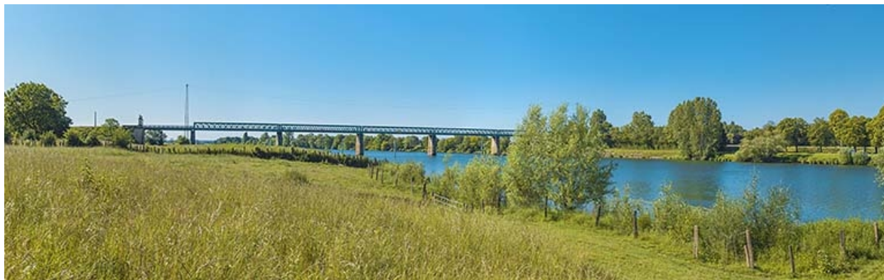
Vue d'ensemble d'amont.
