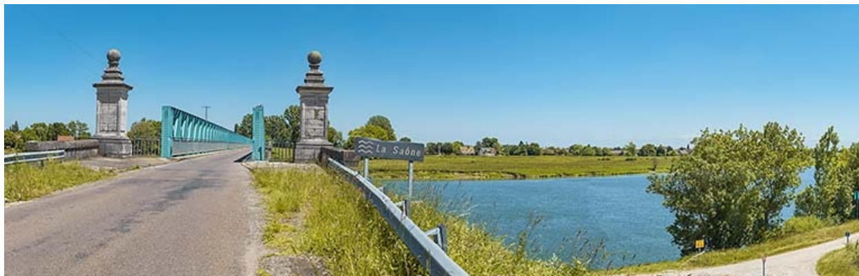
Entrée du pont.
