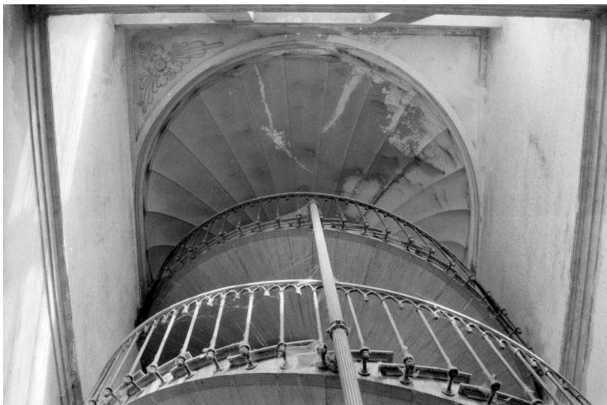
Cage de l'escalier tournant.
