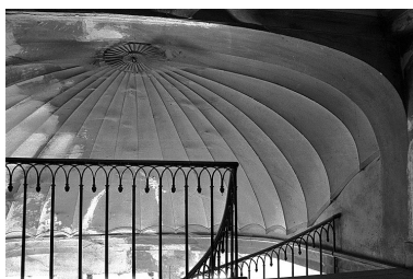
Fausse voûte en cul de four de l'escalier tournant.
