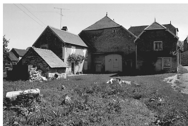
Ferme située ruelle des Forges. Phot. Bernard Lardière IVR43_19817000121Z
