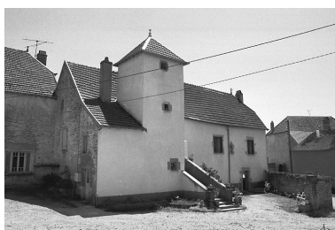
Maison située 3 rue Fénelon. Phot. Bernard Lardière IVR43_19817000126Z
