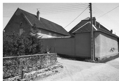
Maison située 13 rue Fénelon. Phot. Bernard Lardière IVR43_19817000124Z
