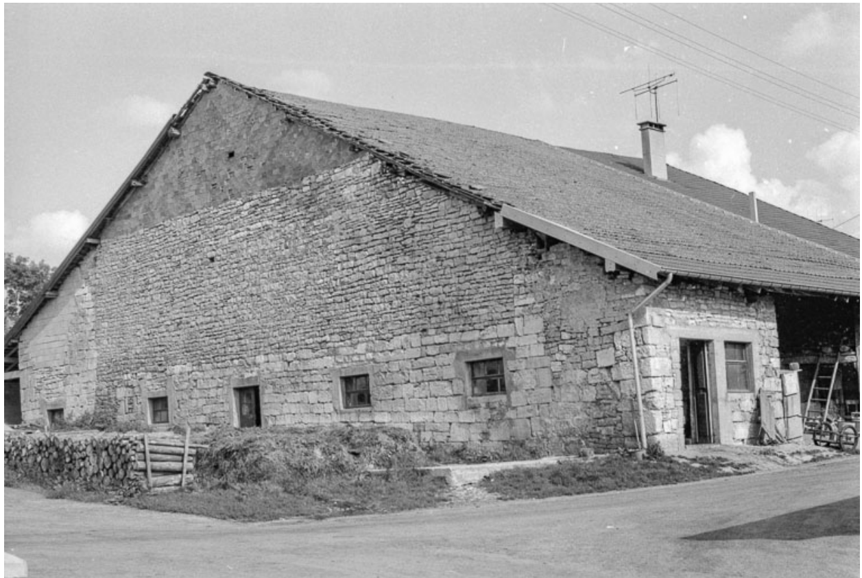
Ferme cadastrée 1945 D 120 : vue d'ensemble.
