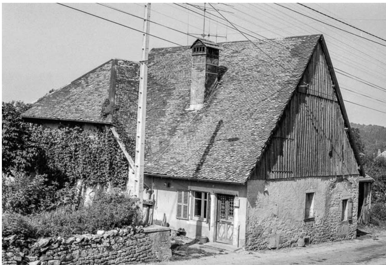
Ferme située rue du Gros Tilleul : vue d'ensemble.
