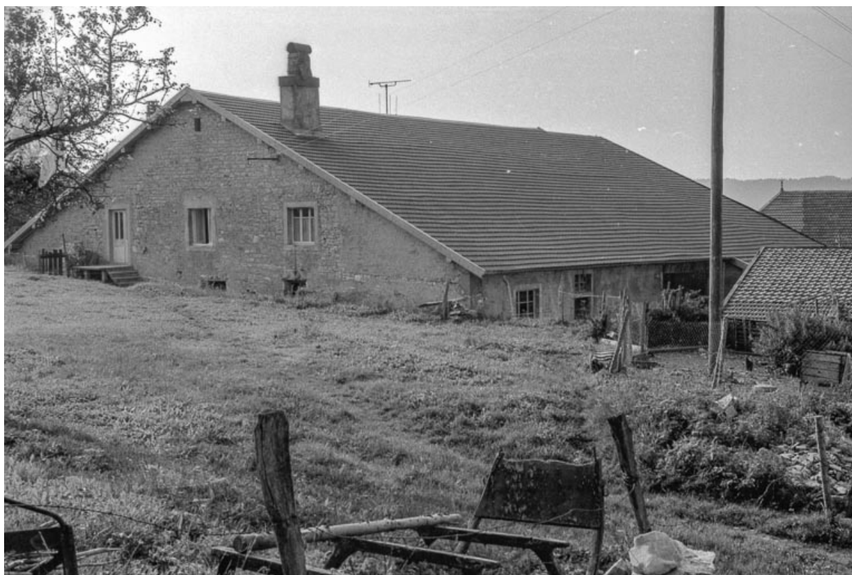
Ferme cadastrée 1945 D 180-181 : vue d'ensemble.
