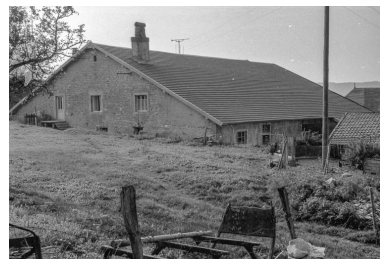
Ferme cadastrée 1945 D 180-181 : vue d'ensemble. Phot. Gilbert Poinot IVR43_19752501288Z
