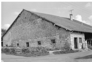
Ferme cadastrée 1945 D 120 : vue d'ensemble. Phot. Gilbert Poinot IVR43_19752501278Z
