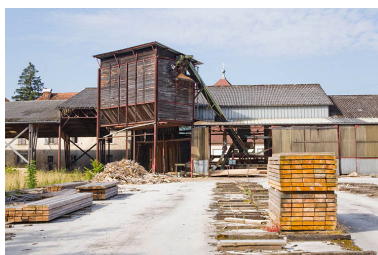
Silo à sciure et hangar de 1969-1970. Phot. Yves Sancey IVR43_20132501274NUC2A
