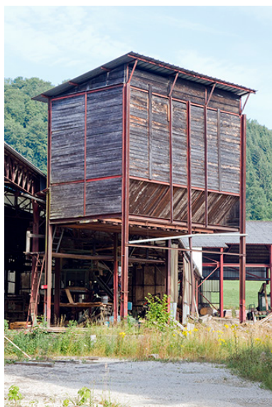
Silo à sciure. Phot. Yves Sancey IVR43_20132501273NUC2A
