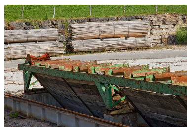
Parc aux grumes : détail du convoyeur. Phot. Yves Sancey IVR43_20132501282NUC2A
