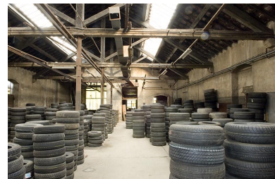
Charpente et couverture
