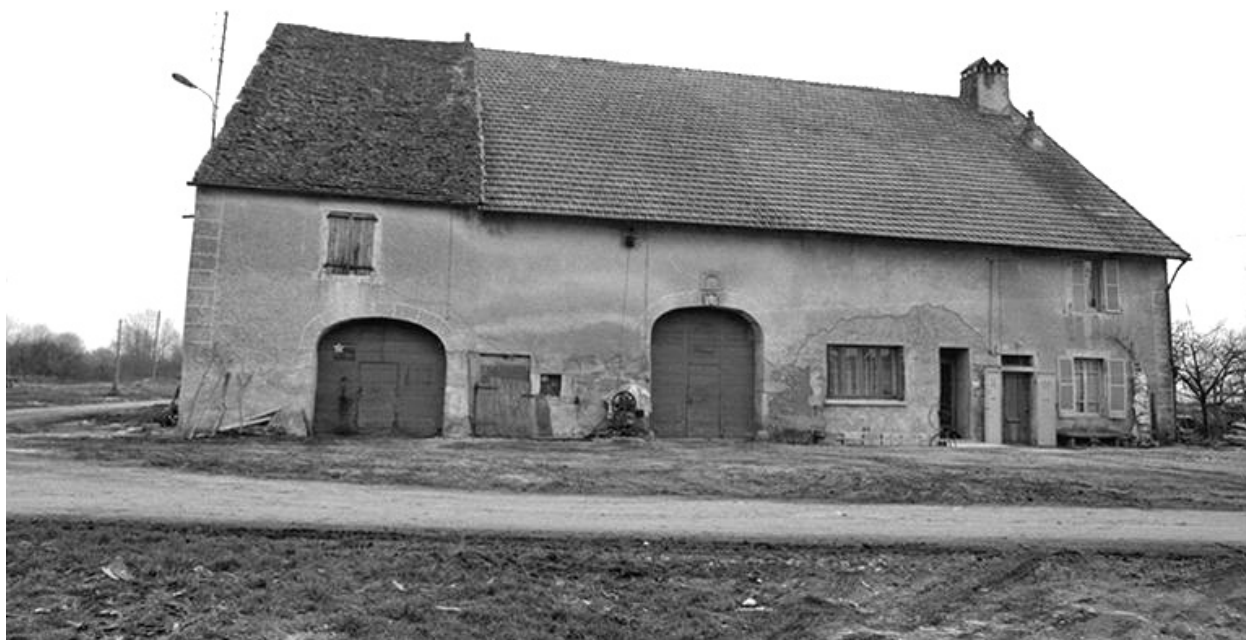
Ferme située le long du chemin vicinal ordinaire n° 4.
