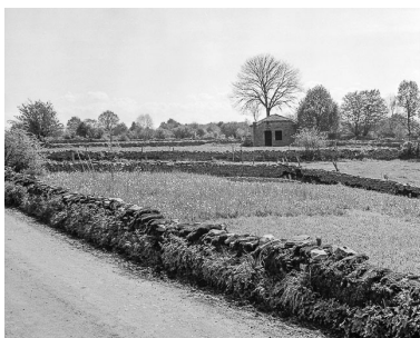
Mur en pierre sèche dit murger.
