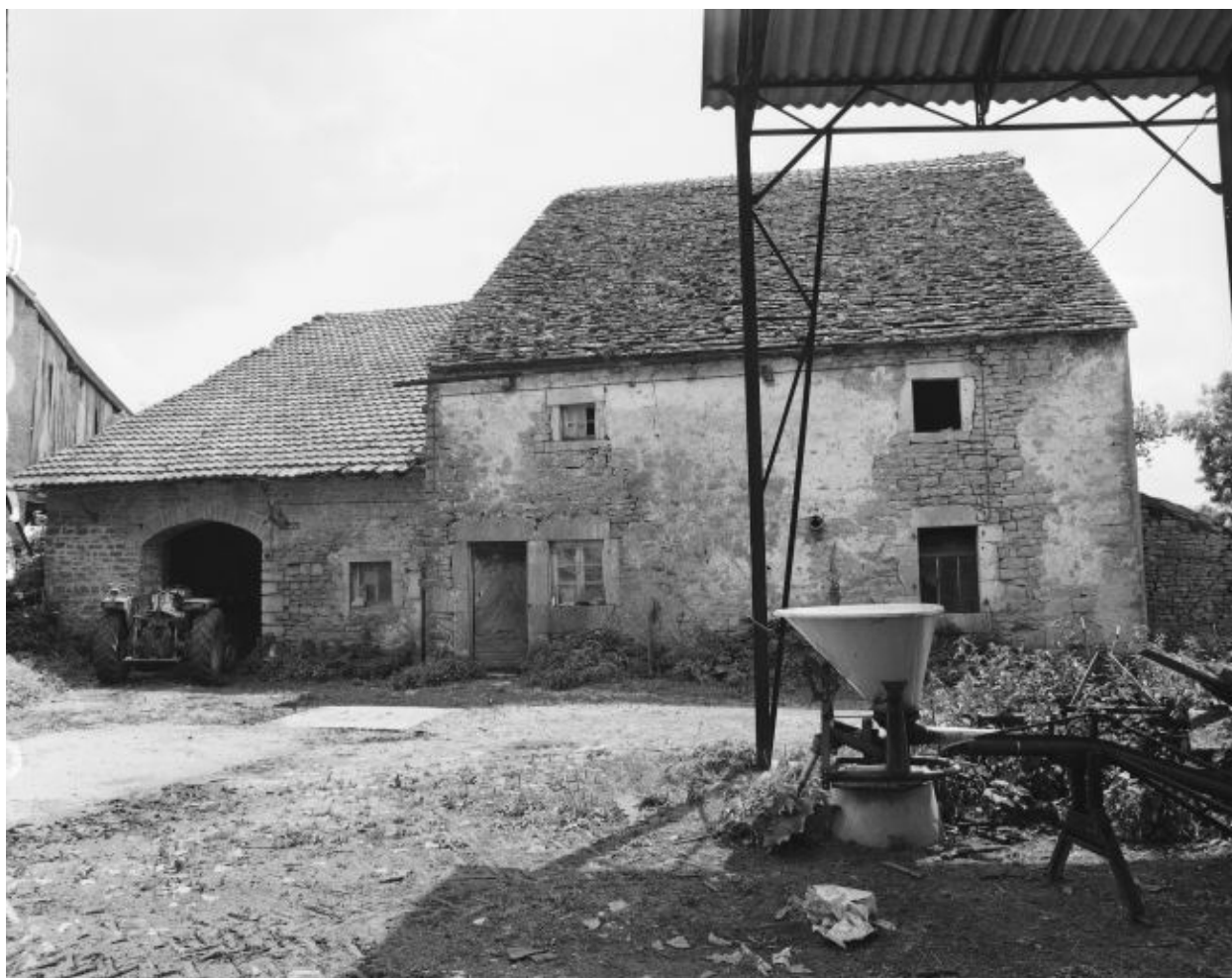
Ferme située rue de l'Oratoire.
