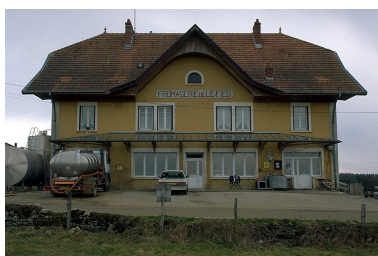
La fromagerie. Phot. Jérôme Mongreville IVR43_19963900078ZA
