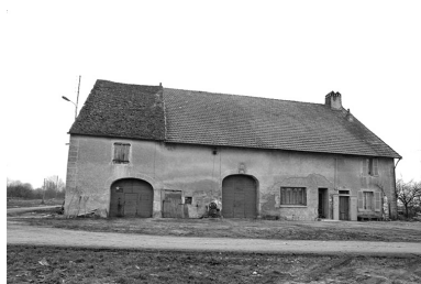
Ferme située le long du chemin vicinal ordinaire n° 4. Phot. F. Pernin IVR43_19743900072Z
