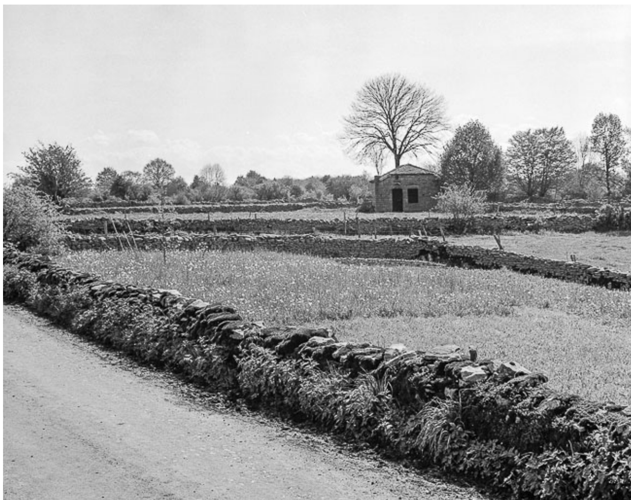
Mur en pierre sèche dit murger.
