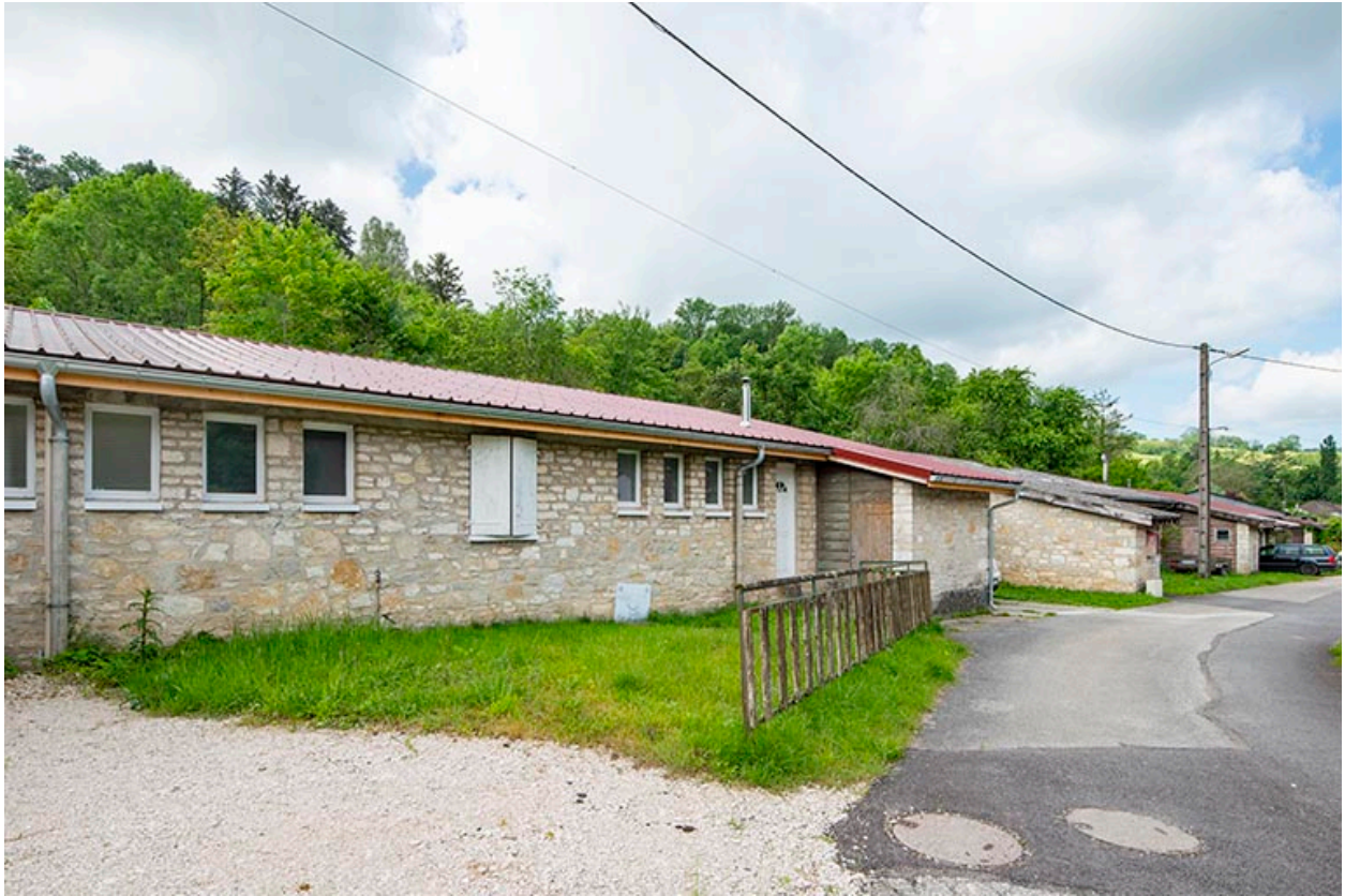
Vue d'ensemble des maisons jumelées.
