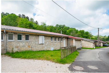
Vue d'ensemble des maisons jumelées. Phot. Jérôme Mongreville IVR43_20243900707NUC4A
